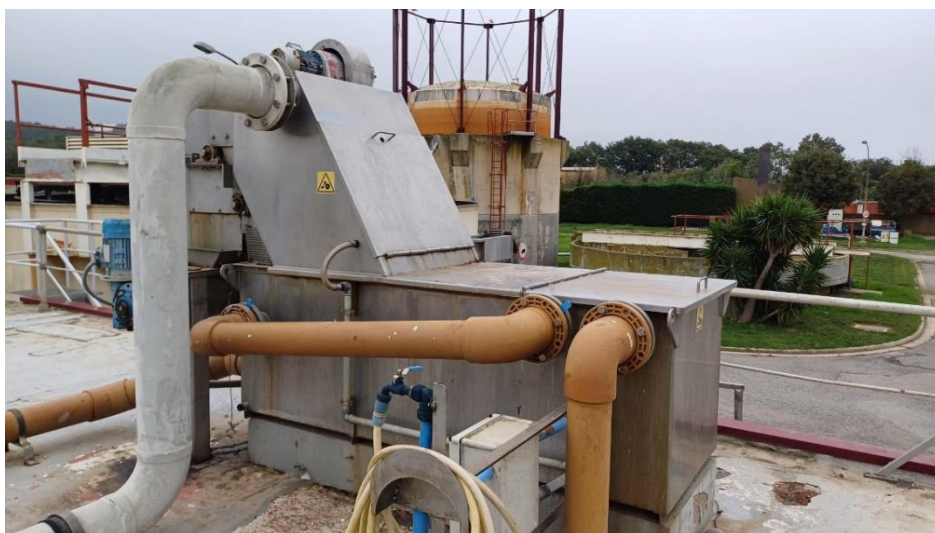
Figura 2. Estació de tamisatge existent
