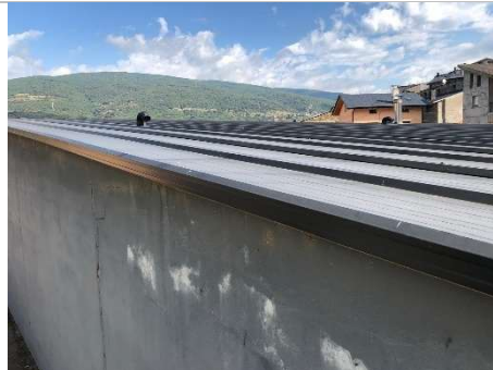
Filtracions de coberta en zones de conductes de ventilació.
