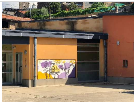
Façana Sud mòdul 1 (trobadra amb mòdul 2)
