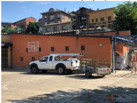
Façana Oest mòdul 2 (Menjador)
