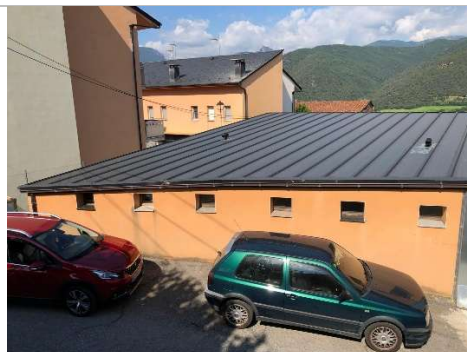
Coberta - façana Sud-Oest
