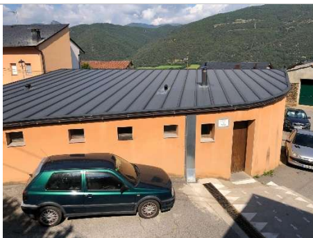
Coberta – Façana sud est.
