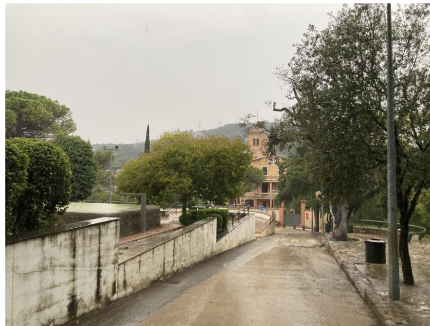
Vista de la carretera d'accés per la carretera de l'Església.
