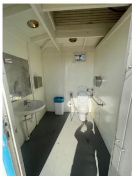
Interior cabina doble servei per persones amb mobilitat reduïda cabina doble
