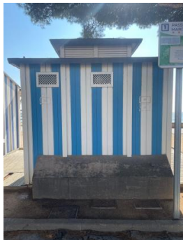
Vista posterior de la cabina doble amb les connexions als serveis soterrats
