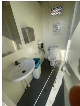
Interior servei homes cabina doble
