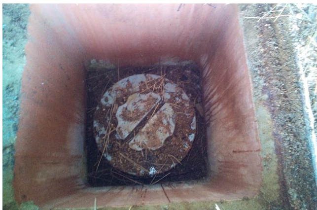
Interior arqueta 40x40 sanejament amb registre posterior cabina sanitària
