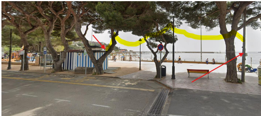
Derivació individual existent per alimentació elèctrica de les cabines sanitàries
