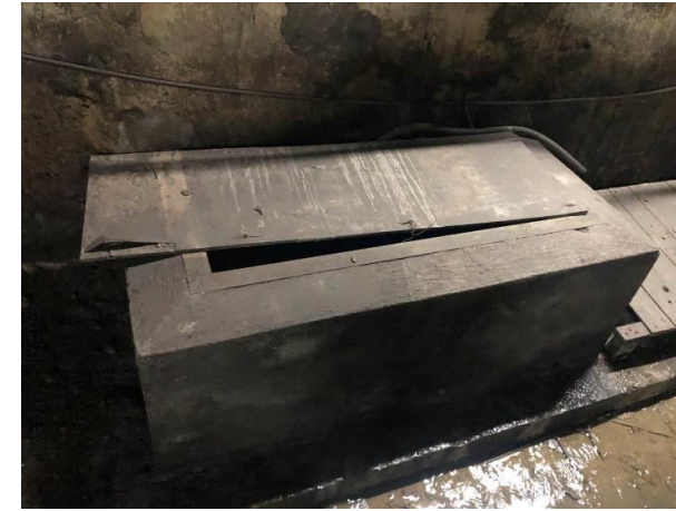
Imatge 17. Tapa pericó desencaixada
