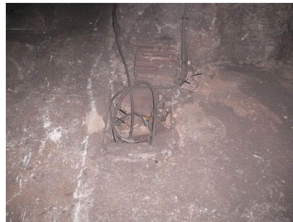
Imatge 2. Absència de tapa de pericó
