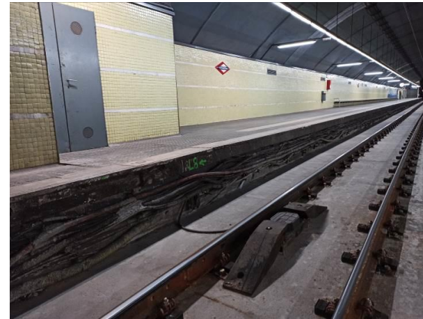
Imatge 62. Estat cablejats Sota andana
