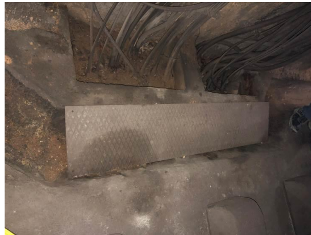
Imatge 11. Reposició de tapa pericó de xapa de ferro estriat
