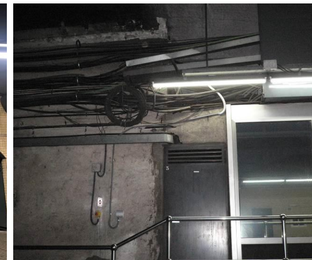
Imatge 8. Canalitzacions a reposar
