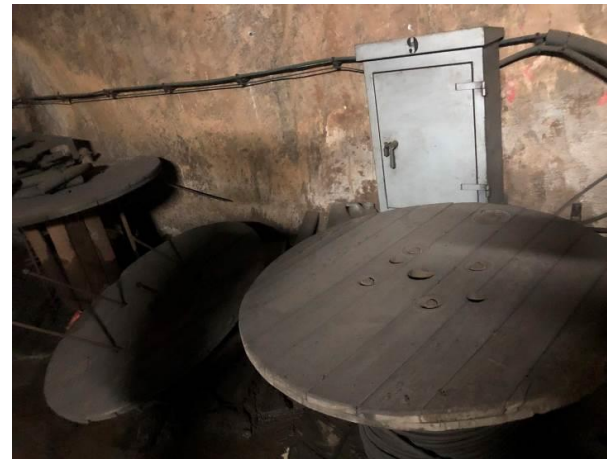
Imatge 12. Bobines de cables a retirar
