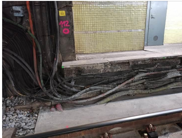
Imatge 61. Estat sota andana (inici)
