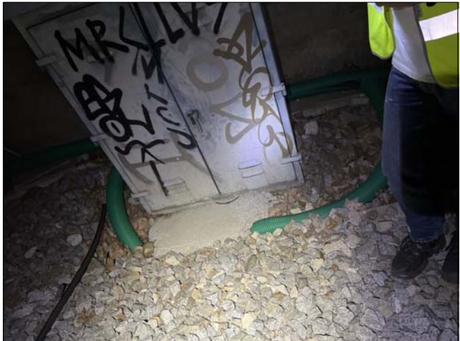
FORMIGONAR PRISMA AL VOLTANT D'ARMARI I TALLAR PORTES PER PERMETRE LA SEVA OBERTURA
