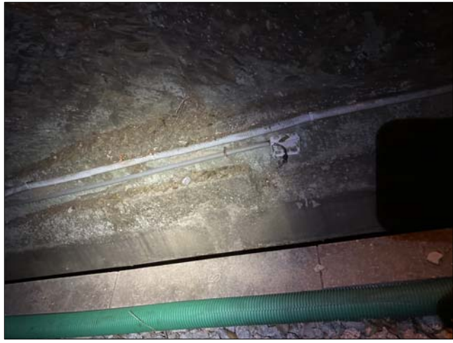
RETIRAR INSTAL·LACIONS DE CAIXA I TUBS FORA DE SERVEI
