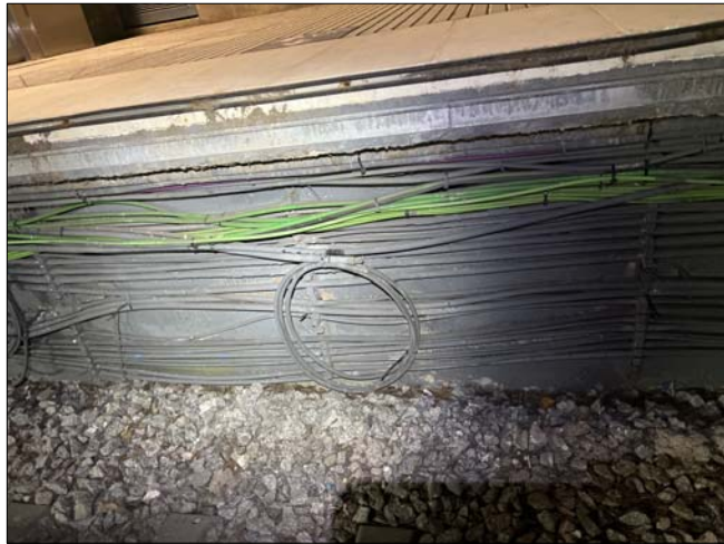
REPOSAR CABLES CAIGUTS EN PERXES I RETIRADA CABLES FORA DE SERVEI
