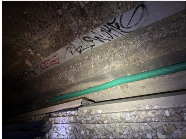
COL·LOCAR UNA CANAL A CADA COSTAT DE LA CUNETETA
