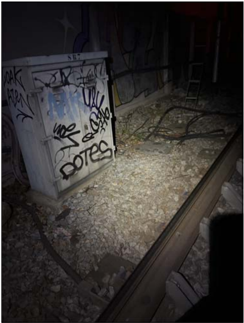
ARMARI SENYALITZACIÓ SR7 DESPLAÇAR JUNTA PER COL·LOCAR CANALS
