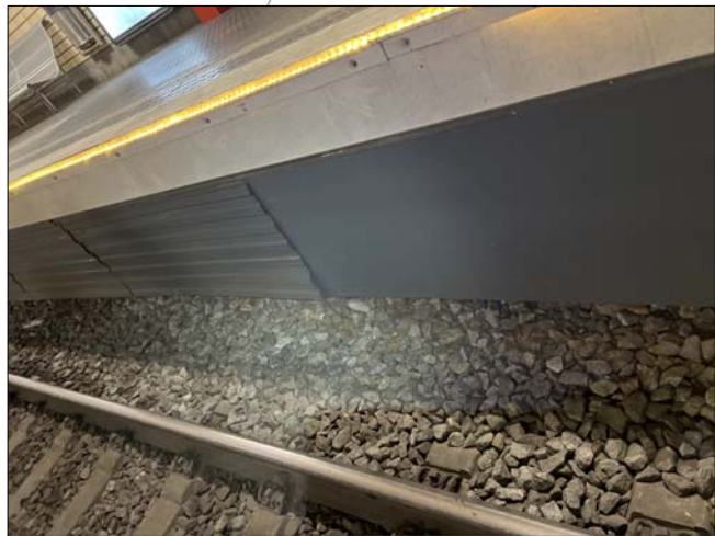
RETIRAR TANCAMENT SOTA ANDANA I COL·LOCAR PORXO
