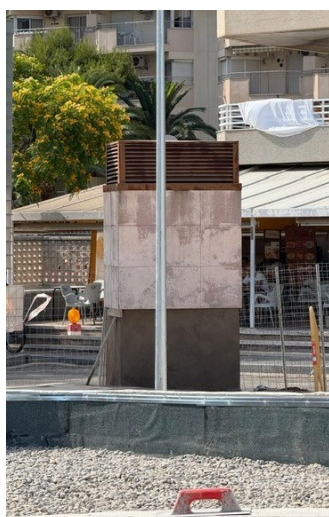
Imatges dels acabats de les respiracions forçades de l'aparcament.
