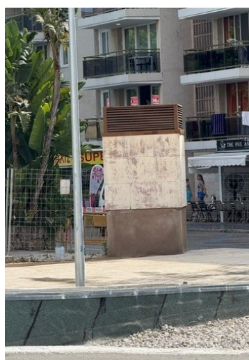
Imatges dels acabats de les respiracions forçades de l'aparcament.
