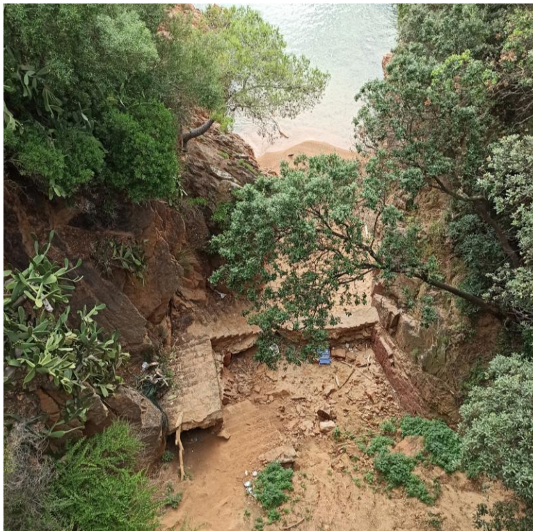
Imatge 2. Vista de l'estat actual de la cala des del pont de la carretera de S'Agaró a Sant Feliu de Guíxols.
