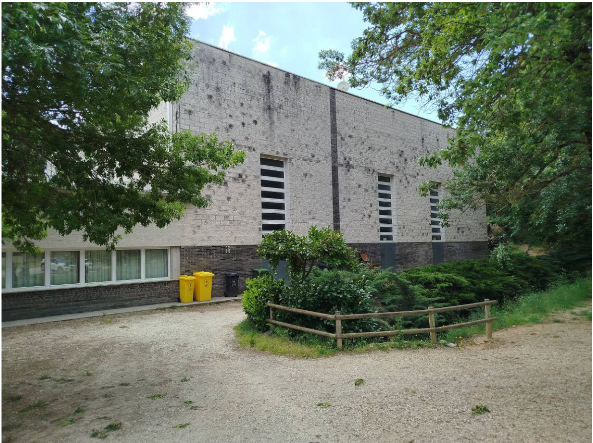
Vista de la façana exterior nord-est
