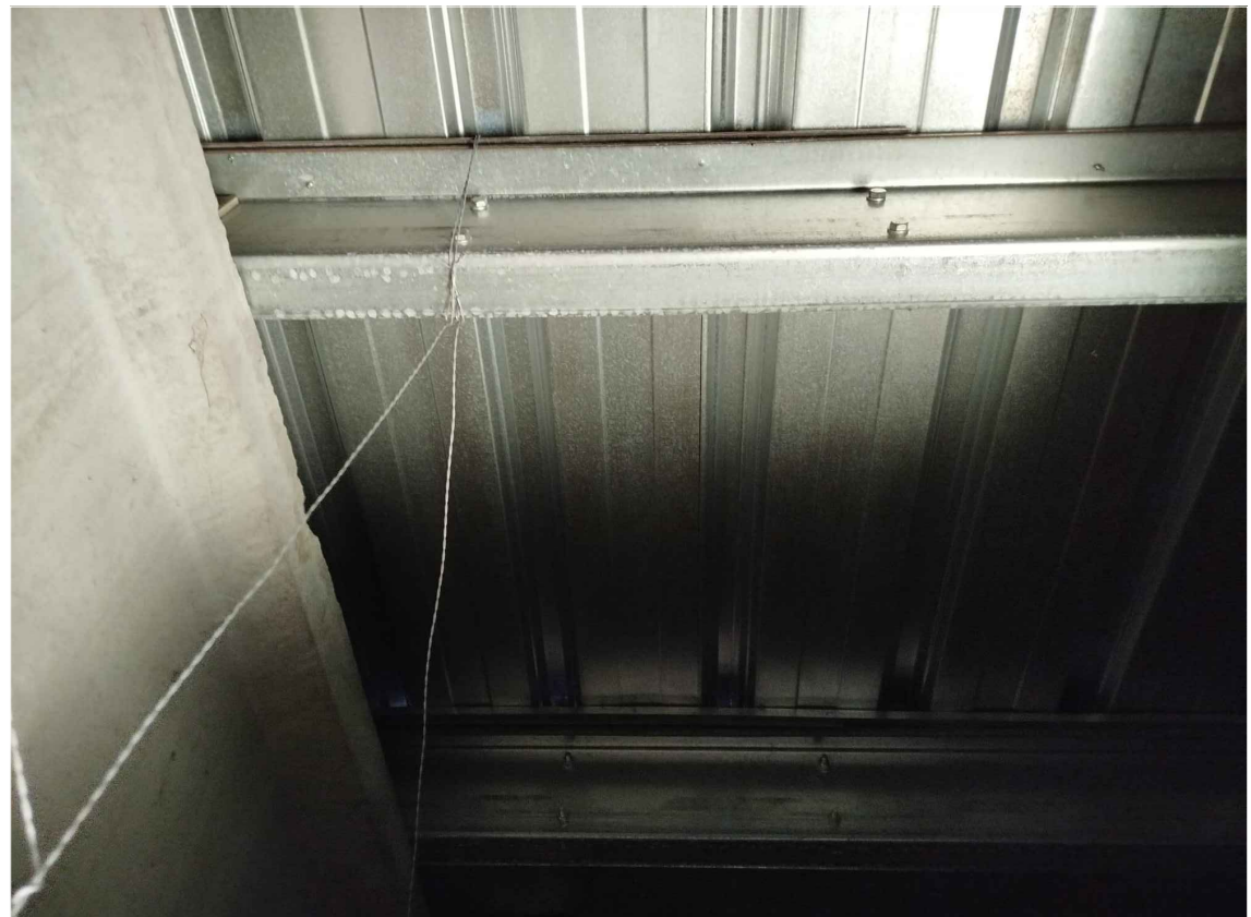
FOTO INTERIOR DE LA COBERTA
