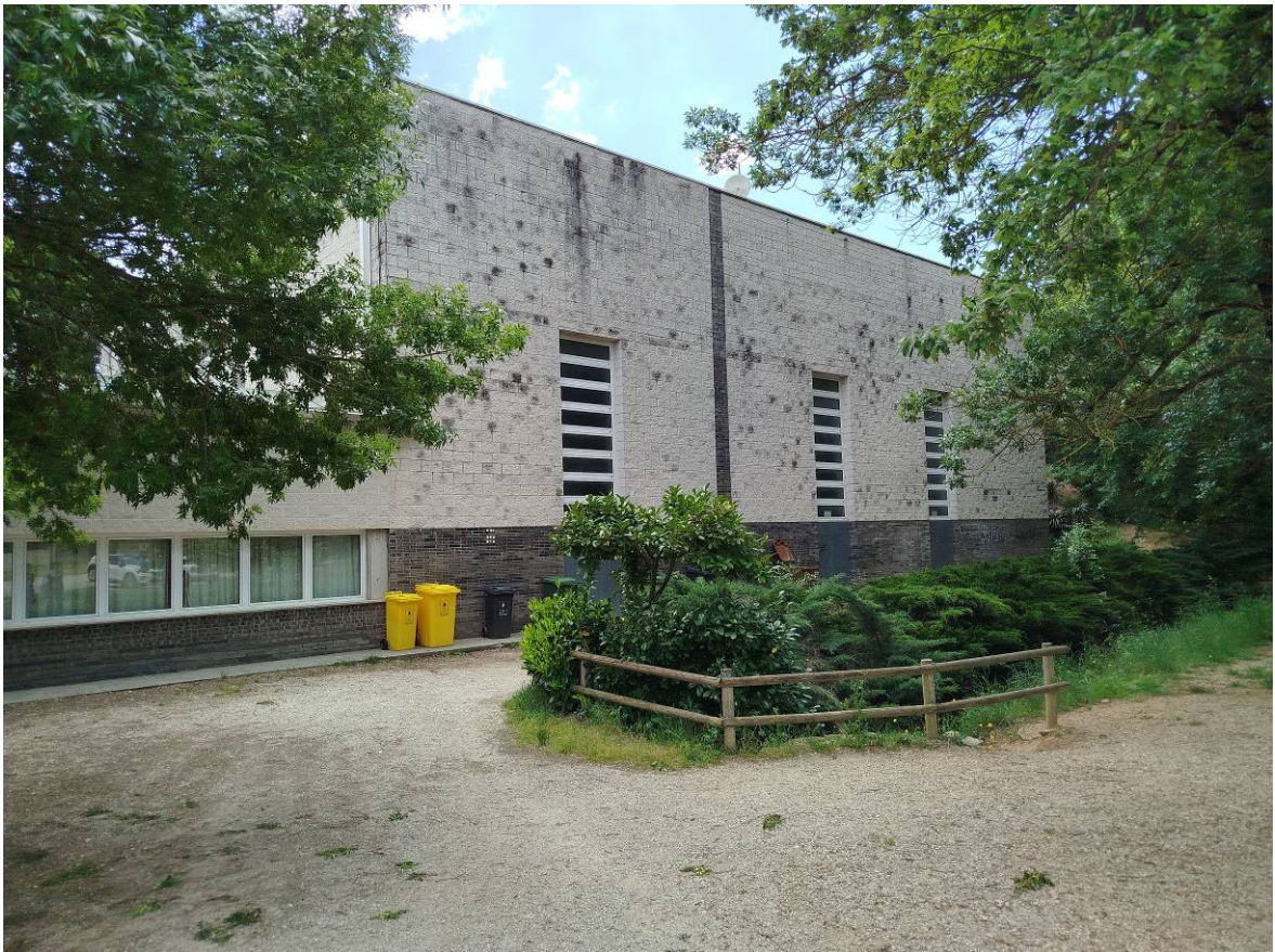
Vista de la façana exterior nord-est
