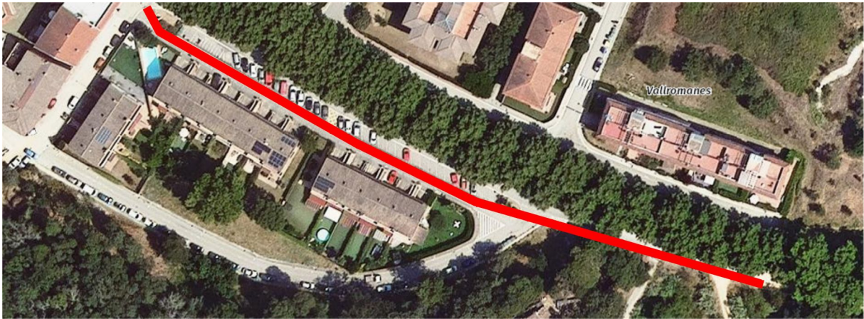
Font GOOGLE on cal executar l'actuació per adequar al transit de vianants
