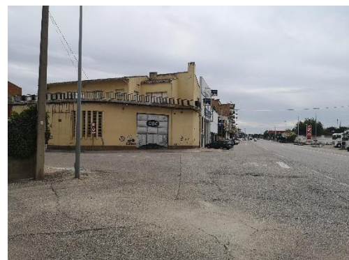
Imatge 4. Manca d'infraestructura per vianants a la cruïlla amb el camí de les Planes que connecti amb el pas de vianants.
