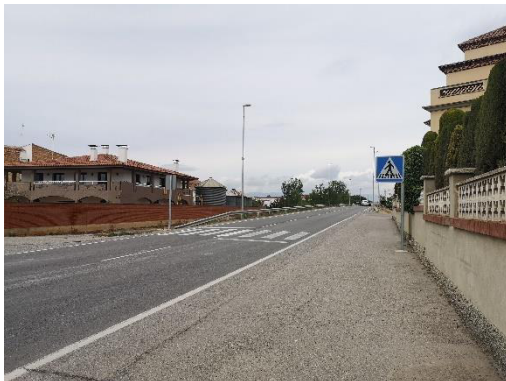
Imatge 2. Vista general del pas de vianants de la C-14 en sentit Artesa de Segre. Voreres inexistentes per accedir al pas. Els vianants caminen pel voral de la carretera.
