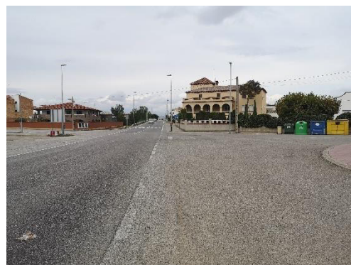
Imatge 5. Gran amplitud de la calçada a la cruïlla. Indefinició dels usos i manca d'infraestructura per a vianants.
