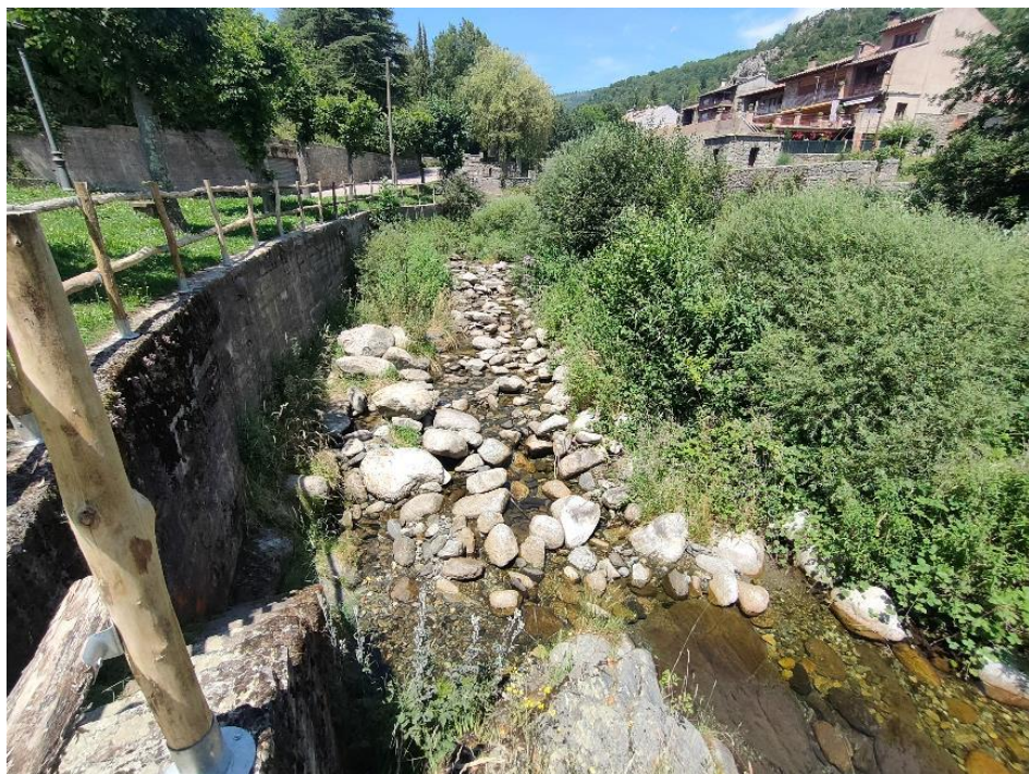
Imatge 7: A la dreta, la illa principal que caldrà treure (plena de vegetació herbàcia, arbustiva i arbres de creixement ràpid però encara amb port arbustiu). Els còdols i sediments s'aniran dipositant a la base del mur, (esquerra imatge) i es facilitarà que el curs de l'aigua passi pel mig de la secció, on ara hi ha la illa.
