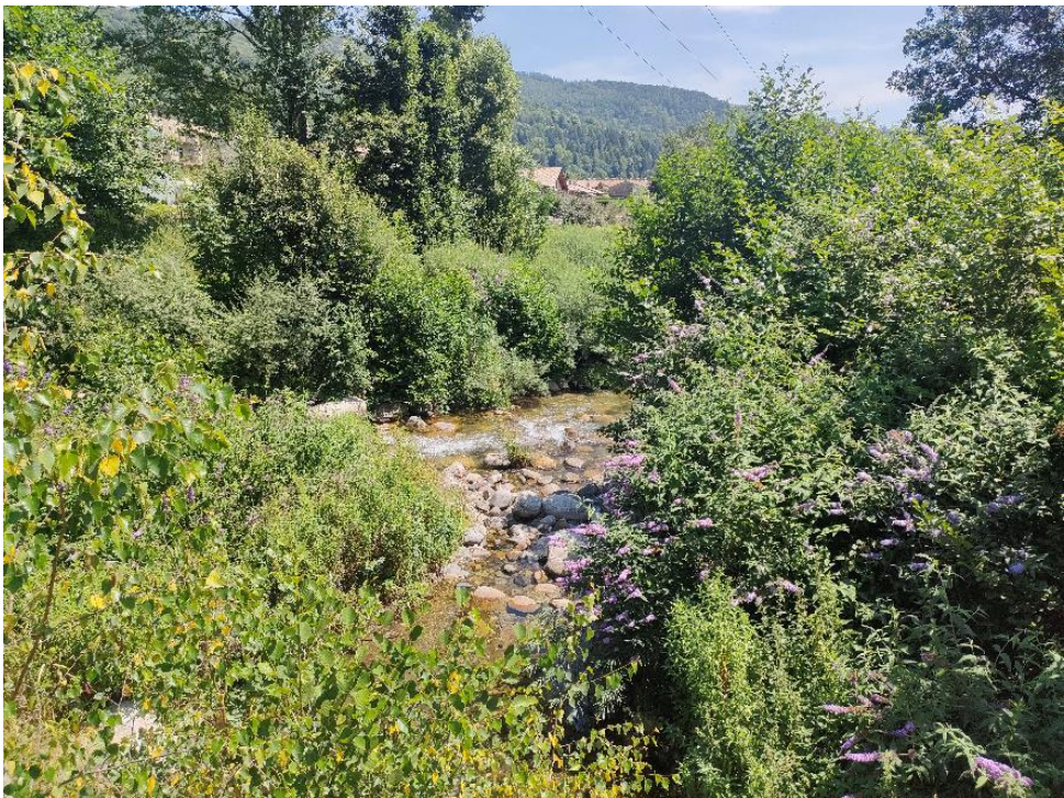
Imatge 9: Part baixa de la illa, on els 2 ramals es tornen a unit. La màquina giratòria pujarà des de la rampa d'accés fins a aquest punt per a desmuntar les illes. A la imatge es pot veure la gran quantitat de budleia que hi ha a la zona.
