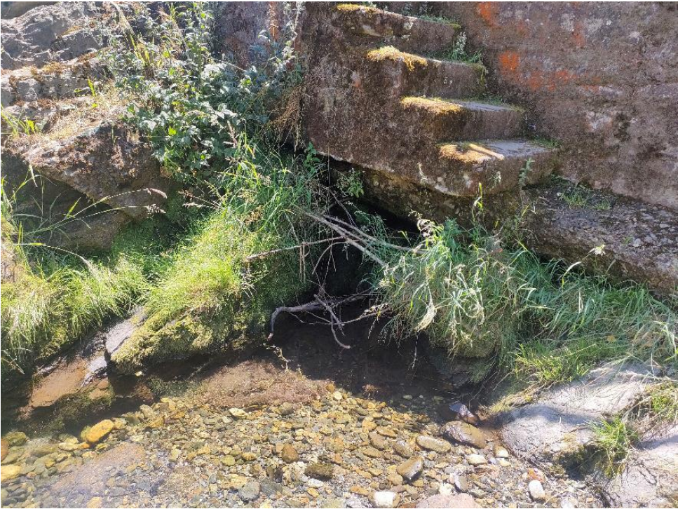
Imatge 5: Sector on s'està descalçant un dels murs.
