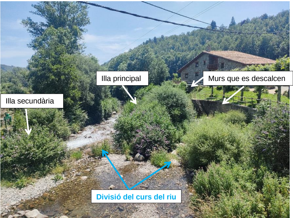
Imatge 1: Visió general de la zona d'actuació. Al centre de la imatge es veu la illa principal, mentre que a la dret es veu el mur que aguanta la zona del carrer i la casa de Can Gordo. La illa ara separa el curs del riu en dues seccions.
