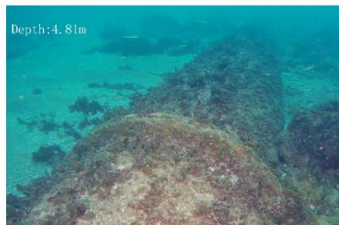
Unió 3 sense protecció:
