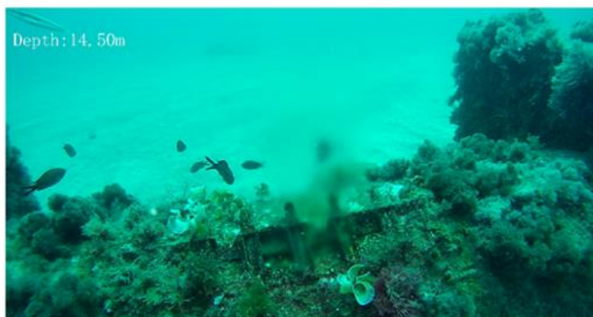
Figura 3. Maniguet d'unió amb fuites (tram de canonada PEAD)
