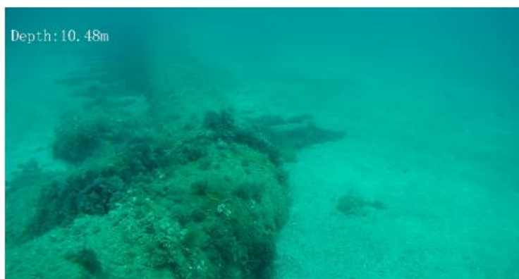
Figura 2. Unions i colzes sense protecció
