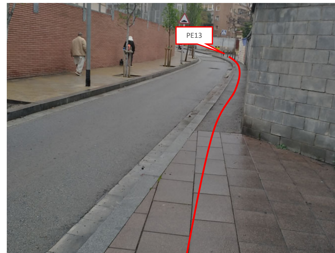
Nova canalització convencional de tipus 4c125 entre el nou pericó PE12 al nou pericó PE13.
