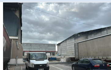
Figura 2: Estat actual del mòdul 8D2 enderrocat després d'un incendi
