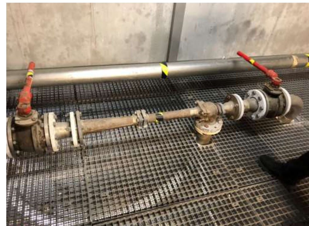
Figura 42. Venturi filtres de carbó vells.
