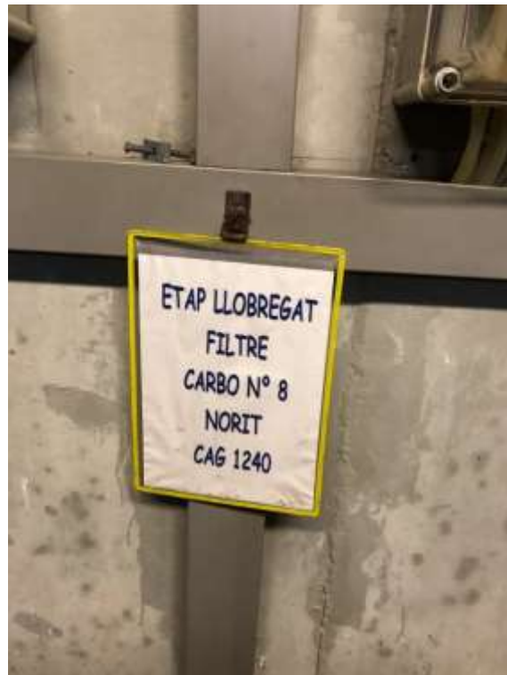
Figura 40. Identificació del carbó actiu dels filtres de carbó vells.
