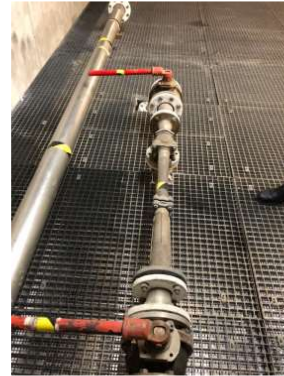
Figura 41. Venturi filtres de carbó vells.
