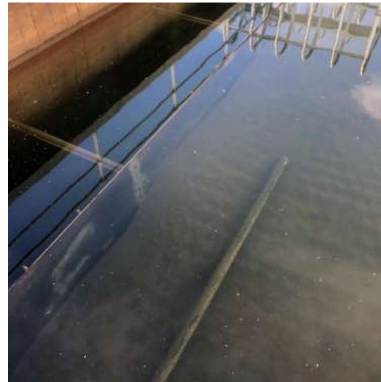
Figura 7. Filtres de sorra vells actuals. Sobreeixidor recrescut amb placa d'acer.
