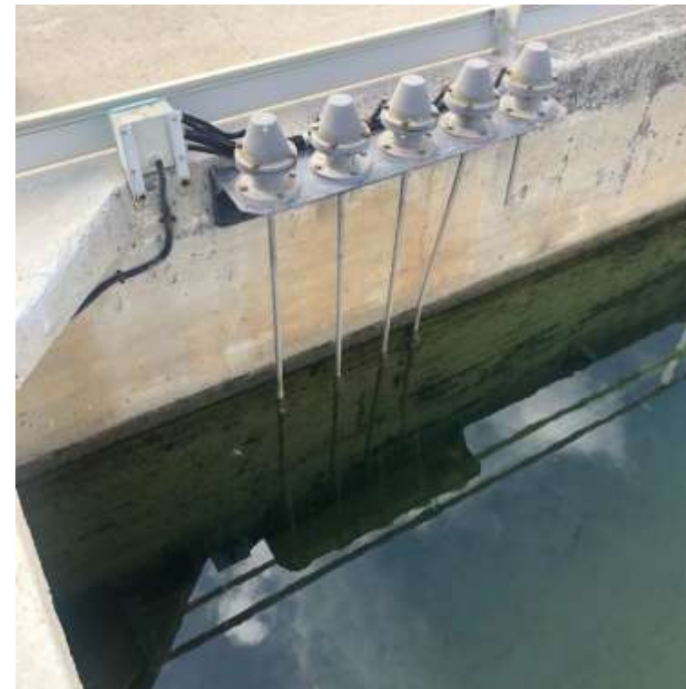
Figura 6. Filtres de sorra vells actuals. Sensors de nivell.
