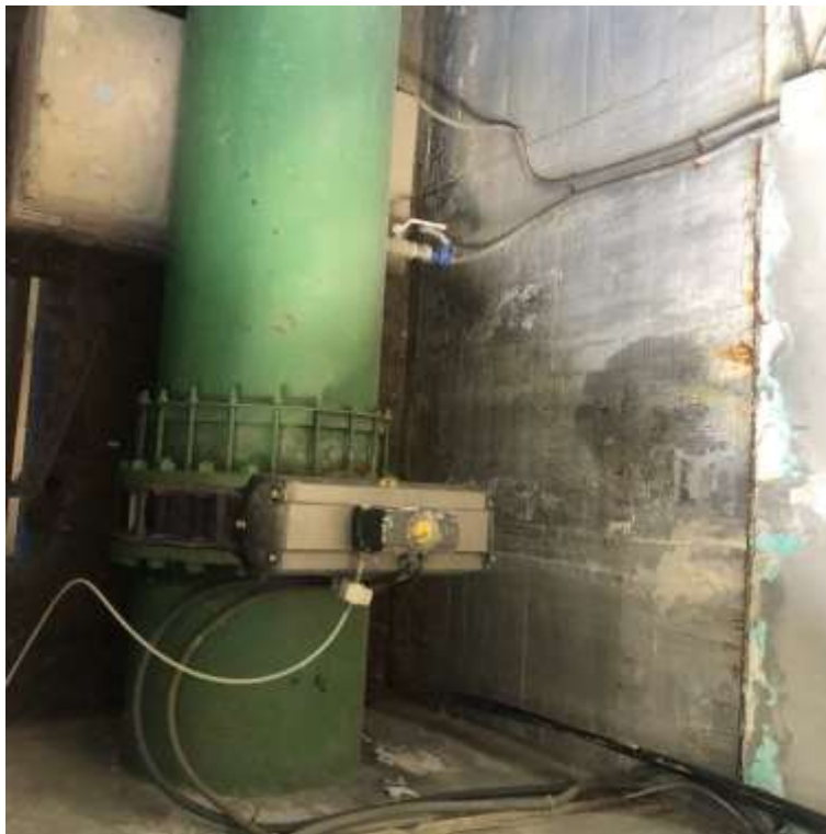
Figura 28. Actuadors valvuleria galeria de rentat dels filtres de sorra vells
