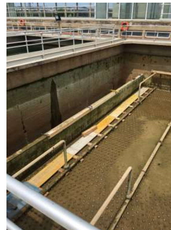
Figura 11. Filtres de sorra vells. Vista del sistema de distribució d'aire, aigua de rentat i recollida d'aigua. Actuació anterior a la redacció del projecte.
