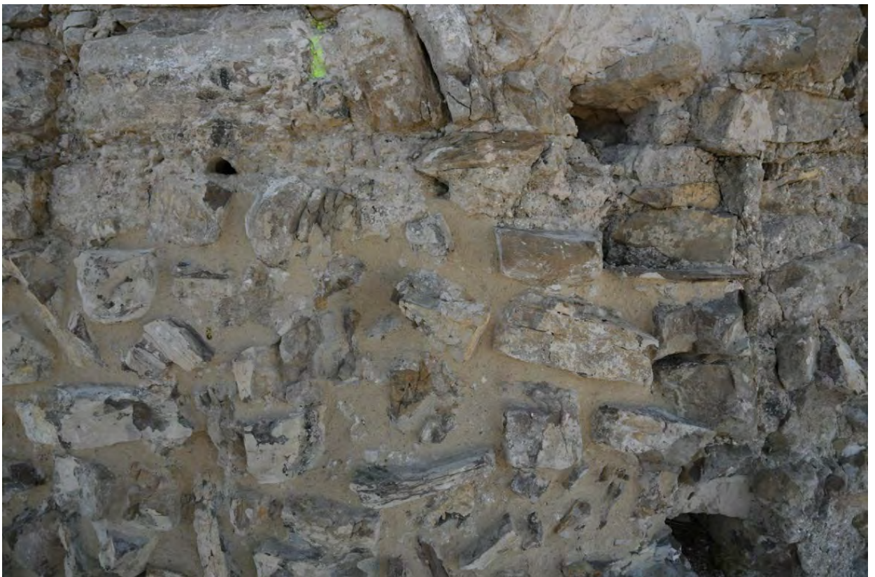
Mostres de rejuntat i escardejat del parament, amb morter de calç àeria CL90- S., plantejat en la visita de 2024,07.08, i fotografiades el 31 de juliol.
