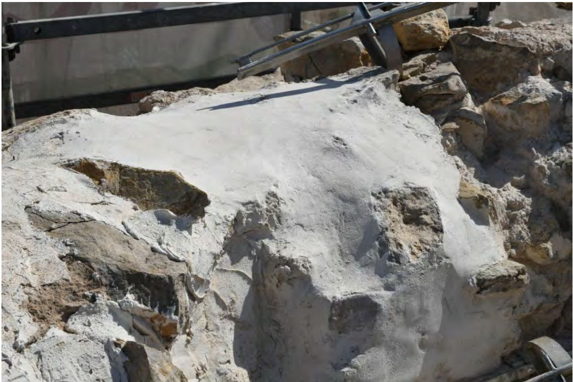
Mostra del procés de restauració estructural de l'empit del terrat, utilitzant morter mixt de calç àeria i guix , al 50%. Mostra realitzada el 19 d'abril i fotografiada el 31 de juliol, amb un envelliment satisfactori.
