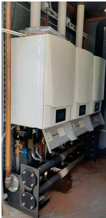
Grups d'equips de producció de calefacció i aigua de primari per acs a desplaçar.
