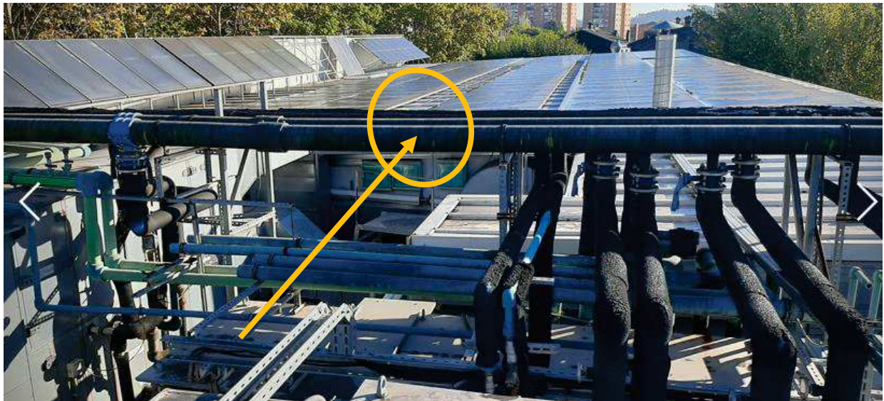
Punt de connexió de les instal·lacions per coberta amb els anells de primari de calefacció i acs de la instal·lació existent.
