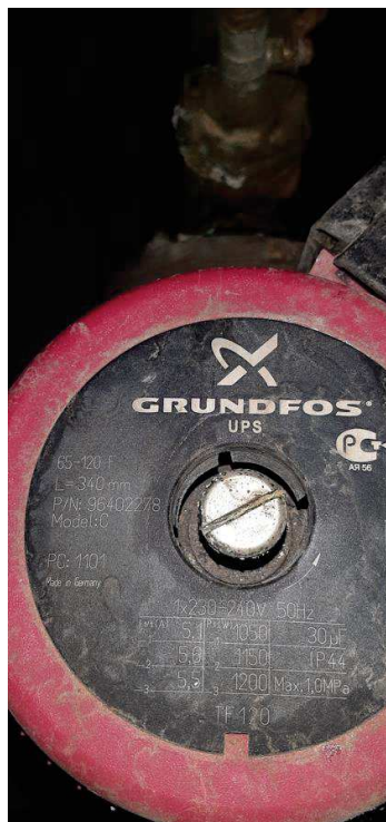
Circulador de l'anell de producció de primari per acs a substituir.
