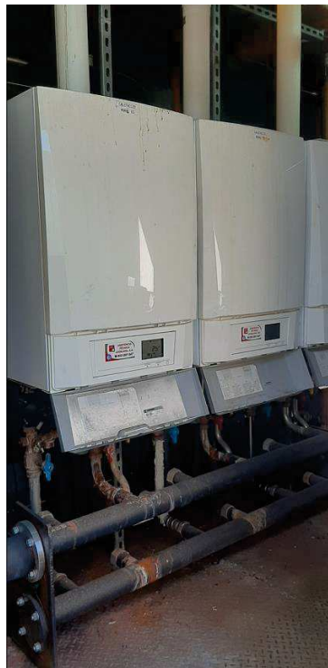
Grups d'equips de producció de calefacció i aigua de primari per acs a desplaçar.
