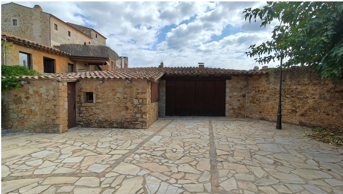
Vista de l'exterior del bar
