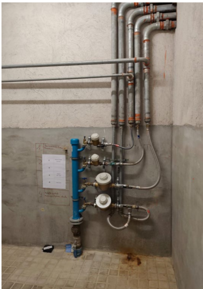
Figura 6. Tancament bateries d'aigua amb armari pladur
