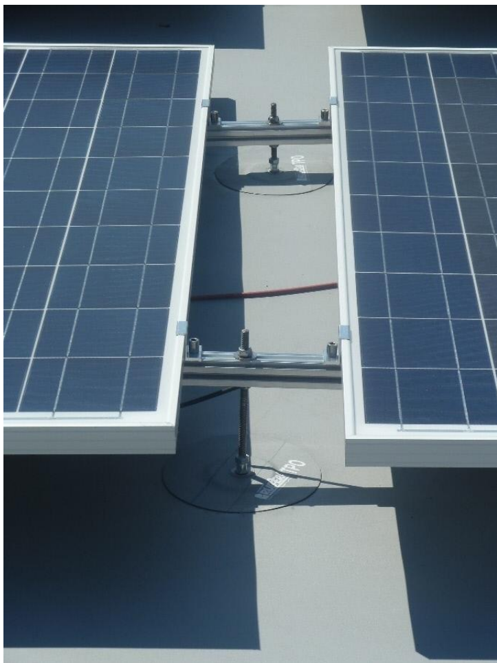
Sistema RubberFix puesto en obra
