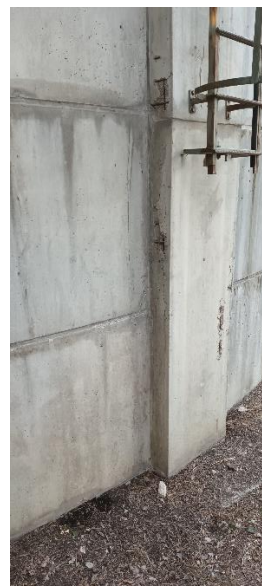
Imatge 6: Vista general d'un dels pilars amb diversos punts escrostonats
