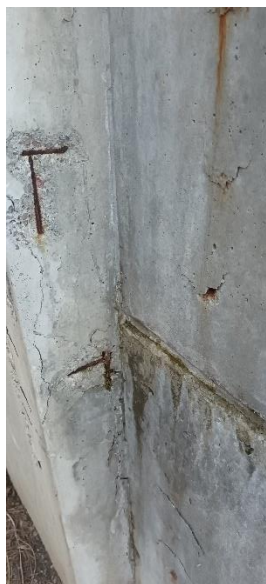
Imatge 7: Detall d'un dels punts escrostonats
