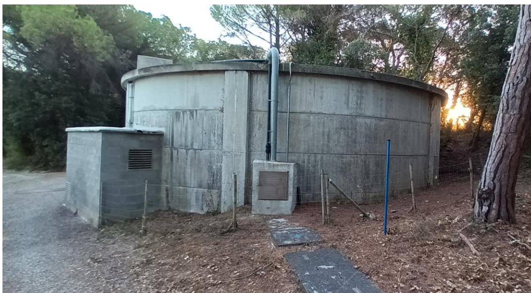
Imatge 4: Imatge general del dipòsit
