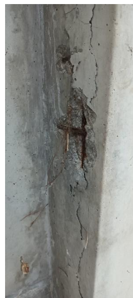
Imatge 8: Detall d'un dels punts escrostonats
