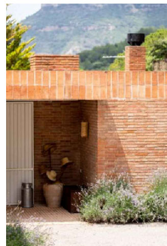
Revestit de maó vertical sobre les obertures de finestres
