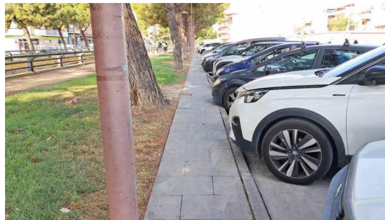
Fotografia 6. Estat de la vorera a condicionar
