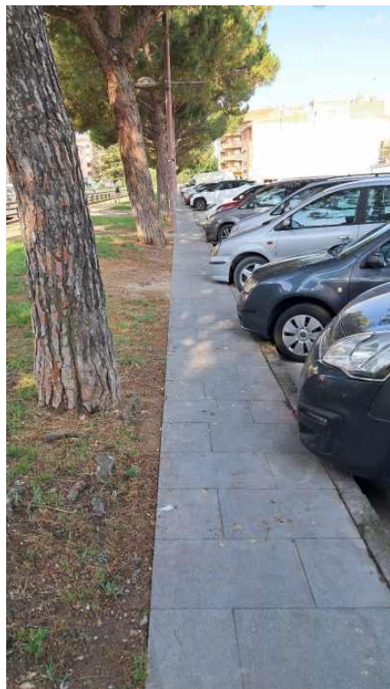
Fotografia 5. Estat de la vorera a condicionar
