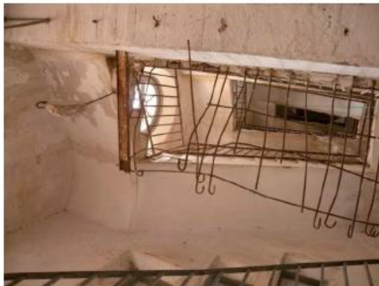
Vista des de sota de les restes del voladís de planta segona, que ha estat enderrocant i només queden les armadures
