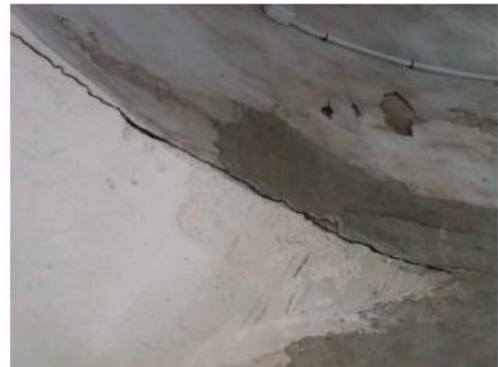
Esquerda resseguint la transició entre la forma rectangular del torreó i l'el·lipse de la cúpula
