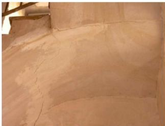
Segon tram d'escala entre planta quarta i cinquena, amb esquerdes perpendiculars a la volta que es perllonguen pel mur de façana
