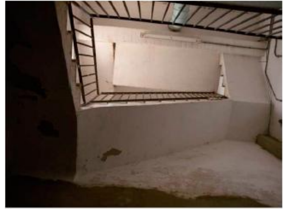
Segon i tercer trams ascendents des de planta baixa, en aquest cas rectilinis sense forma de volta, possiblement formats per lloses de formigó armades
