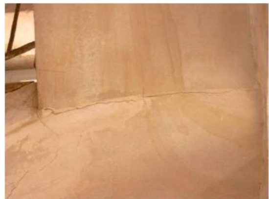
Segon tram d'escala entre planta quarta i cinquena, amb esquerdes perpendiculars a la volta que es perllonguen pel mur de façana
