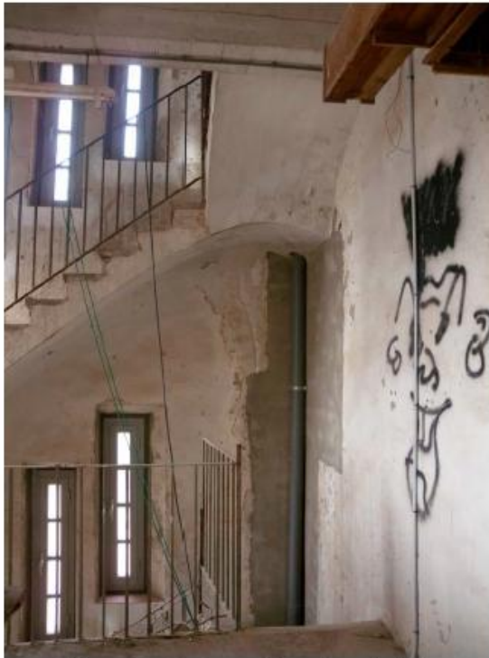
Esquerda sota el segon i tercer trams de planta segona a tercera que parteix la volta d'escala i descendeix pel mur
