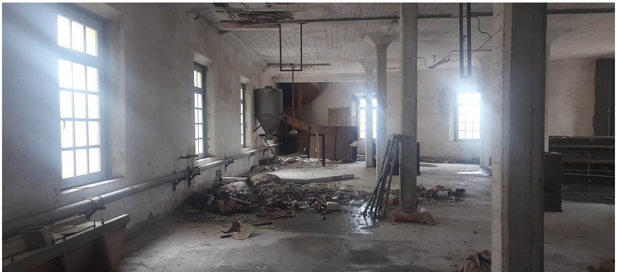
Filtracions d'aigua en planta baixa provinents de canals de coberta a la nau lateral est (Carrer Camí Vell de Castellnou)
