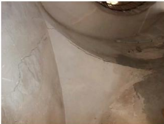
Esquerda resseguint la transició entre la forma rectangular del torreó i l'el·lipse de la cúpula
