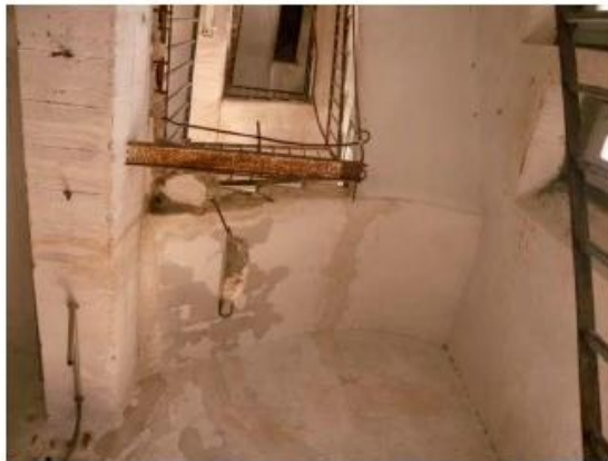
Primer tram ascendent des de planta segona a tercera, amb una esquerda perpendicular al seu traçat a la trobada amb el segon tram que continua com a fissura pel mur
