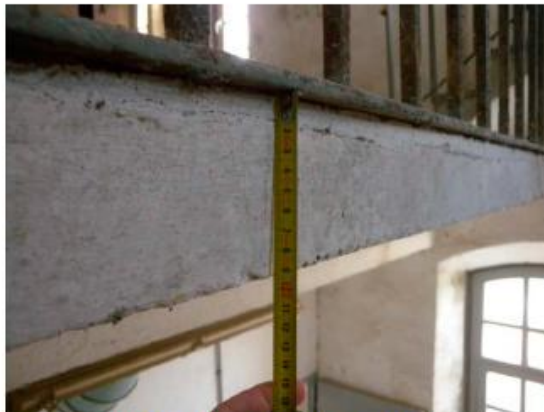
Cantell mínim del voladís al voltant dels 7cm
