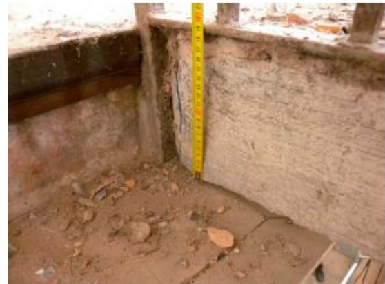
Cantell màxim del voladís al voltant dels 17cm
