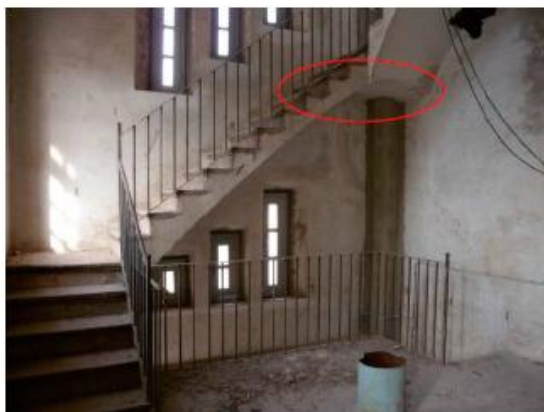
Cantell mínim del voladís al voltant dels 7cm
