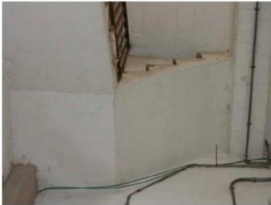
Segon i tercer trams ascendents des de planta baixa fins a planta primera, en aquest cas rectilinis sense forma de volta, possiblement formats per lloses de formigó armades. També s'observa la cara inferior del voladís que cobreix el forat d'escala a partir d'aquest nivell
