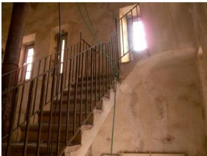
Esquerdes verticals al mur de façana sota la volta del segon tram d'escala entre planta quarta i cinquena
