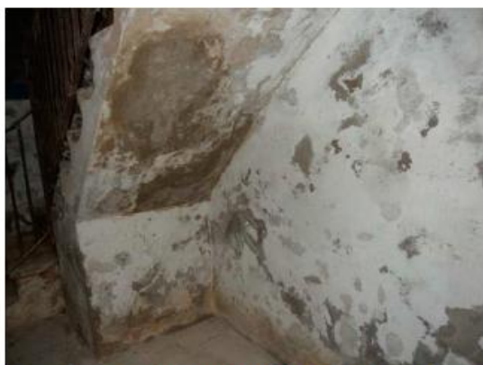
Escales des de la planta semisoterrani fins a les sitges. Les patologies observades són principalment humitats per filtracions a través dels murs, però no s'observen esquerdes
