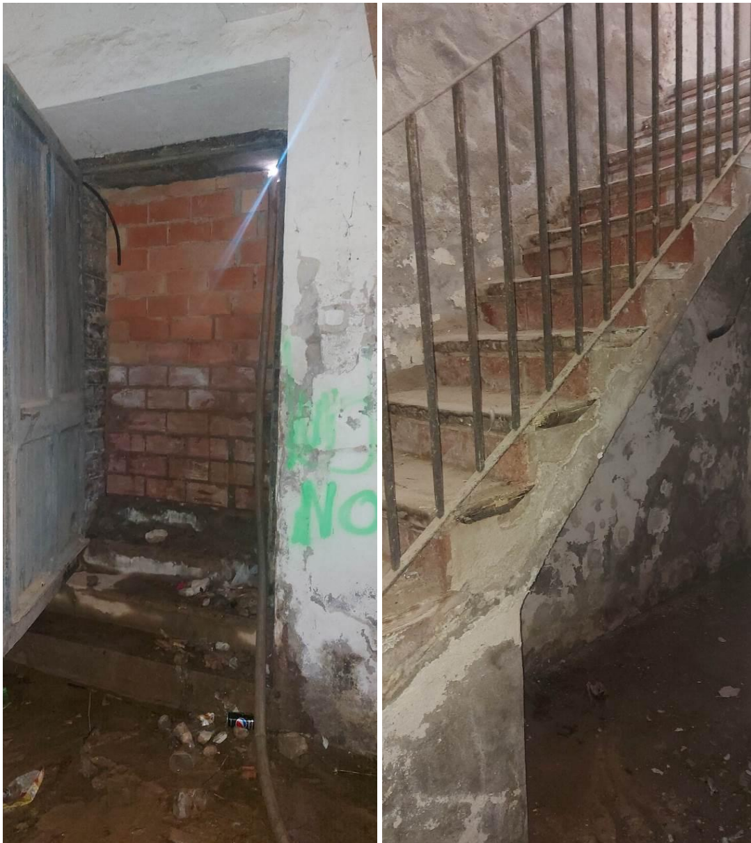
Filtracions d'aigua a l'interior de planta soterrani a la nau central
