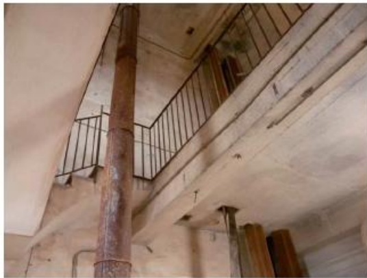
Cara inferior del forjat de planta quarta (altell)
