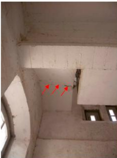
Primer tram ascendent des de planta primera a segona, amb una esquadra perpendicular al seu traçat
