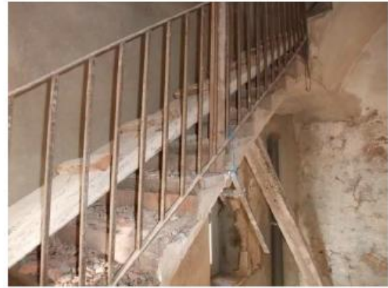
Tram d'escala llarg entre planta quarta i cinquena, molt esquerdat, apuntalat i no trepitjable
