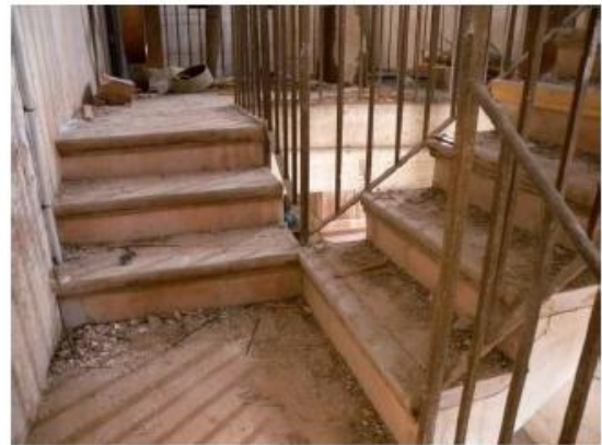
Esgraonat intermig d'accés a la planta quarta (altell)
