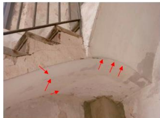
Cantell màxim del voladís al voltant dels 17cm
