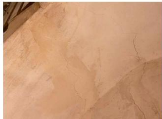
Primer tram d'escala entre planta tercera i quarta, amb esquerdes perpendiculars a la volta que es perllonguen pel mur de façana
