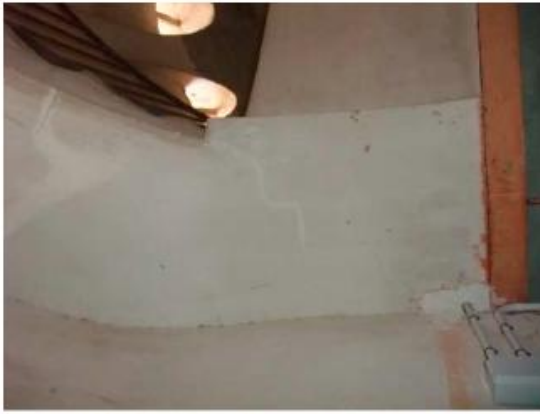
Esquerda perpendicular a la volta al final del tram circular d'escala
