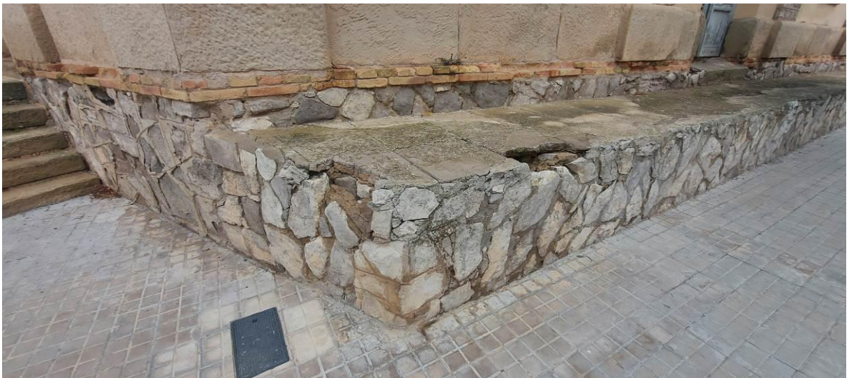
Estat dels murs exteriors en zones de filtracions d'aigua de planta soterrani a la nau lateral
