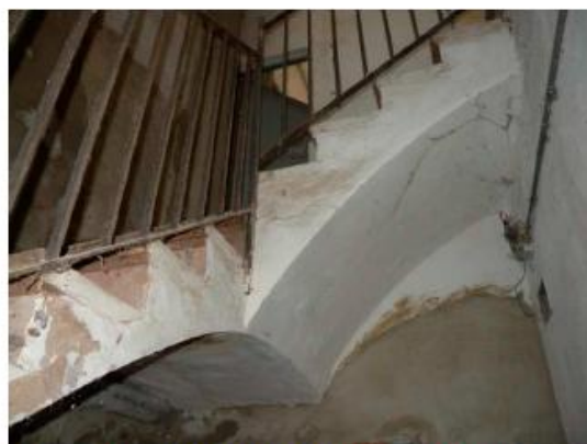
Escales des de la planta semisoterrani fins a les sitges. Les patologies observades són principalment humitats per filtracions a través dels murs, però no s'observen esquerdes
