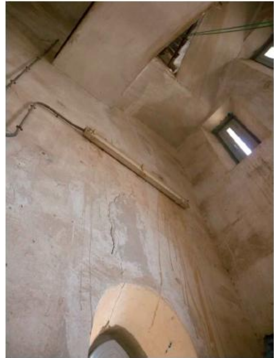
Esquerdes verticals al mur de façana sota la volta del segon tram d'escala entre planta quarta i cinquena
