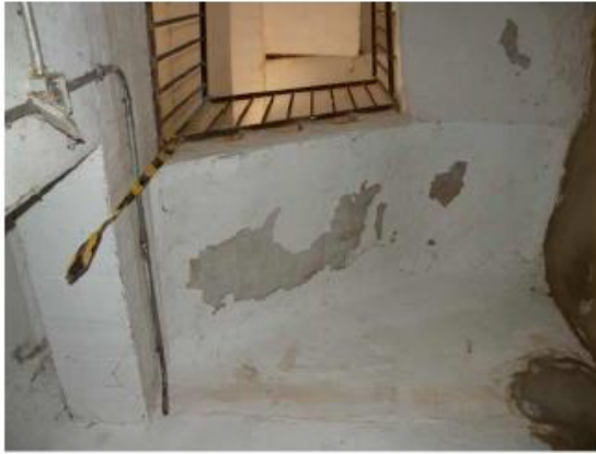
Primer tram d'escala ascendent des de planta baixa amb forma de volta sense esquerdes
