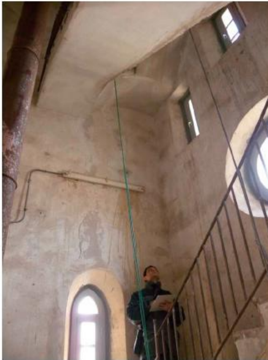
Esquerdes verticals al mur de façana sota la volta del segon tram d'escala entre planta quarta i cinquena
