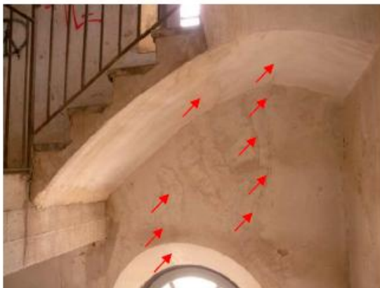
Primer tram d'escala entre planta tercera i quarta, amb esquerdes perpendiculars a la volta que es perllonguen pel mur de façana
