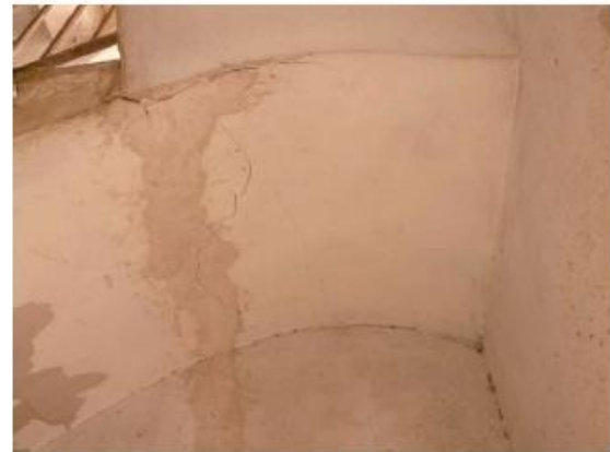
Primer tram ascendent des de planta segona a tercera, amb una esquerda perpendicular al seu traçat a la trobada amb el segon tram que continua com a fissura pel mur
