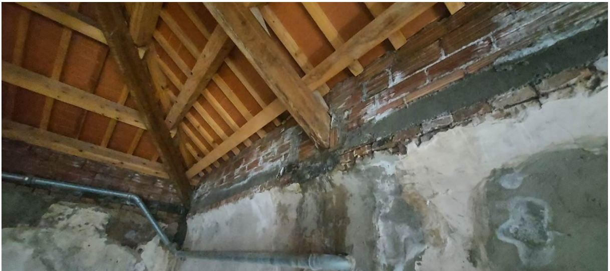
Filtracions d'aigua de canals de coberta a la nau central
