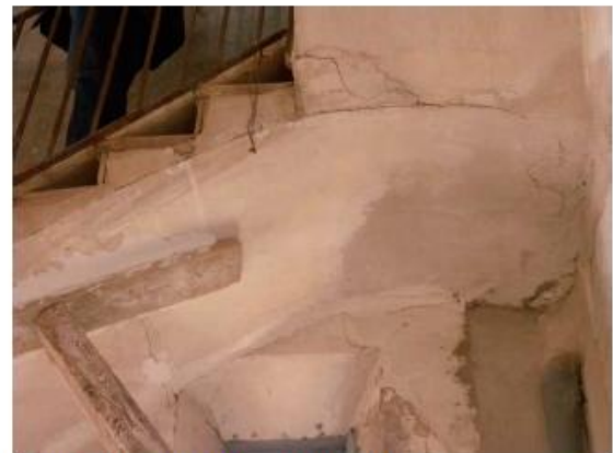
Vista frontal de l'escala entre planta quarta i cinquena, amb el tercer tram molt esquerdat i apuntalat
