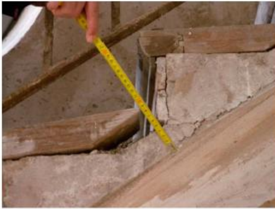
Les voltes d'escala dels trams llargs des de planta tercera i quarta són molt primes, d'uns 4cm de gruix que suposaria dues voltes de maó de pla.
