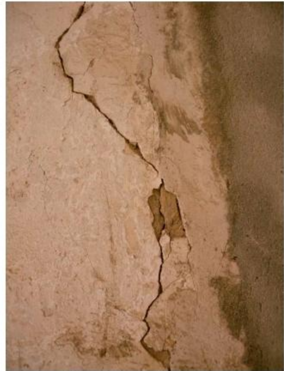
Esquerda sota el segon i tercer trams de planta segona a tercera que parteix la volta d'escala i descendeix pel mur
