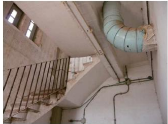
Segon i tercer trams ascendents des de planta baixa fins a planta primera, en aquest cas rectilinis sense forma de volta, possiblement formats per lloses de formigó armades. També s'observa la cara inferior del voladís que cobreix el forat d'escala a partir d'aquest nivell
