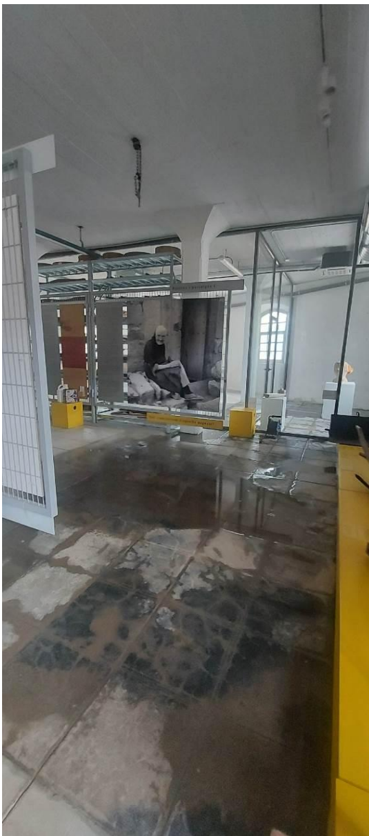
Filtracions d'aigua de canals de coberta a la nau central
