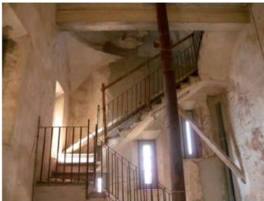
Vista frontal de l'escala entre planta quarta i cinquena, amb el tercer tram molt esquerdat i apuntalat
