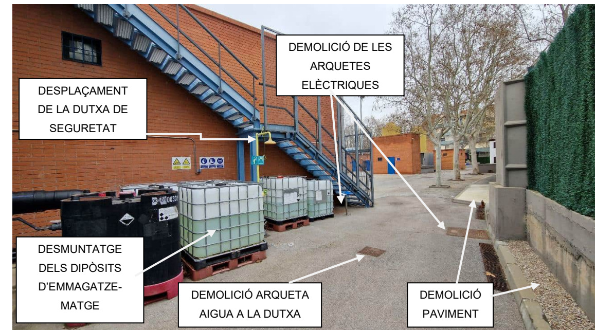
Foto 2.- S'observa: la dutxa d'emergència, les escales i la arqueta elèctrica, elements que seran reubicats, els dipòsits de reactius que es desmuntaran i les seccions de paviment a demolir per a facilitar l'accés als nous filtres. Font: Pròpia
