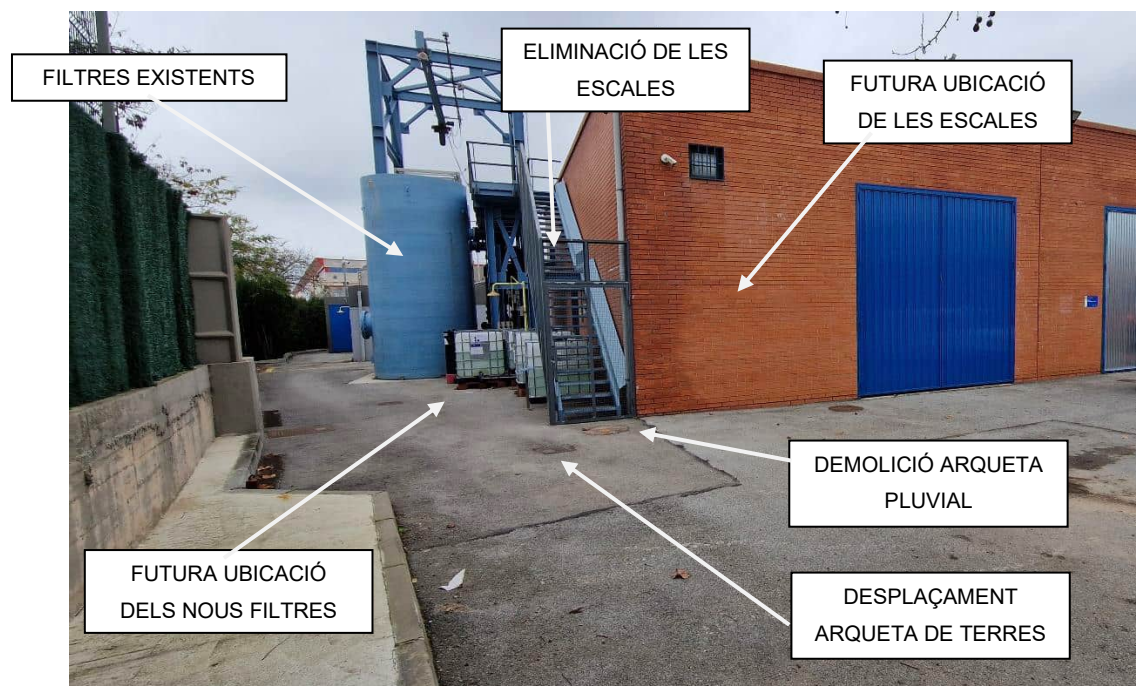
Foto 4.- S'observa la ubicació del sistema actual de remineralització i les actuals escales, elements que seran reubicats per estar col·locats a la futura ubicació on els nous filtres seran construïts. També s'observa la futura ubicació de les escales i la demolició de l'arqueta pluvial i el desplaçament de l'arqueta de terres per a fer espai. Font: Pròpia
