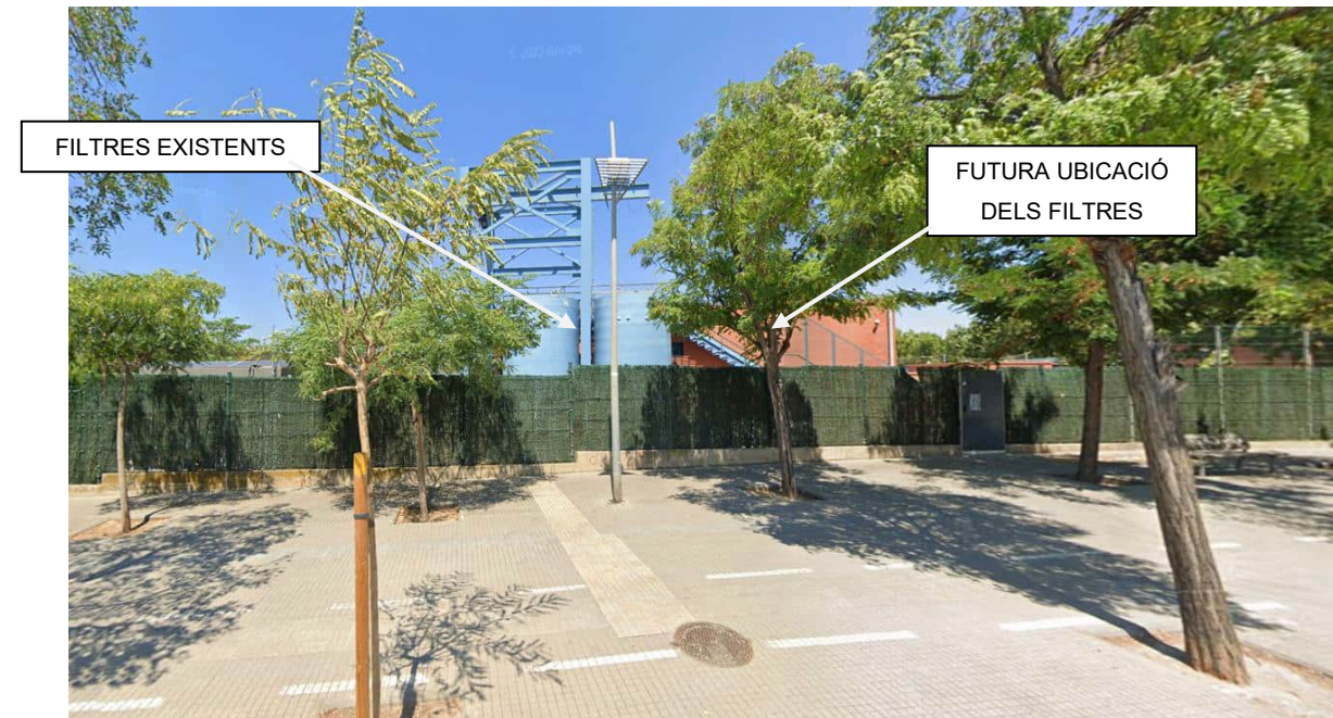
Foto 14.- Vista exterior de l'estació de tractament, on es pot observar la ubicació dels actuals sistemes de remineralització i on es situaran els futurs filtres. Font: Street View, Google Maps
