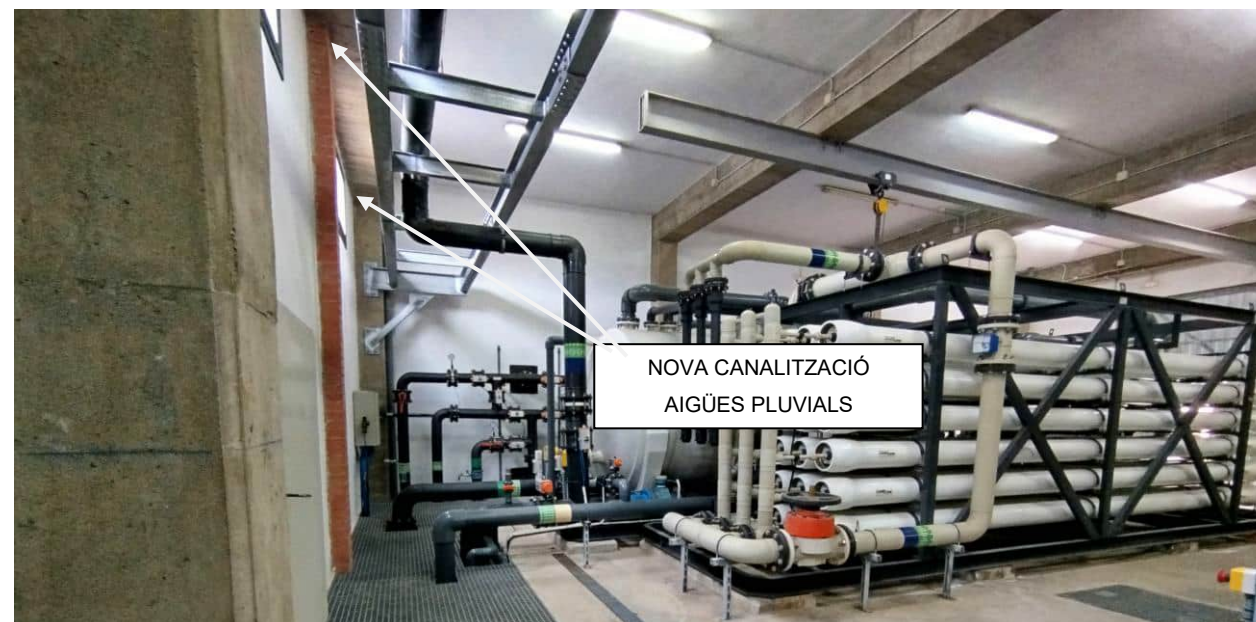
Foto 9.- S'observa l'interior de l'edifici d'osmosi, per on passarà la nova canalització d'aigües pluvials
