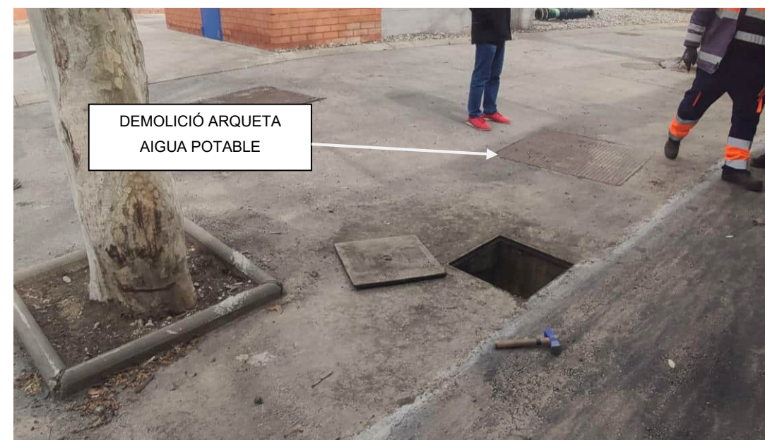
Foto 6.- S'observa l'arqueta d'aigua potable que serà demolida amb la raó de que deixarà de ser funcional al demolir la canonada existent d'impulsió de l'aigua tractada.
