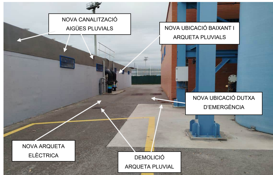
Foto 8.- S'observa la futura localització de la dutxa d'emergència; de la nova arqueta elèctrica; i de la nova canalització, baixant i arqueta d'aigües pluvials. També s'observen les aquetes pluvials existents a demolir.
