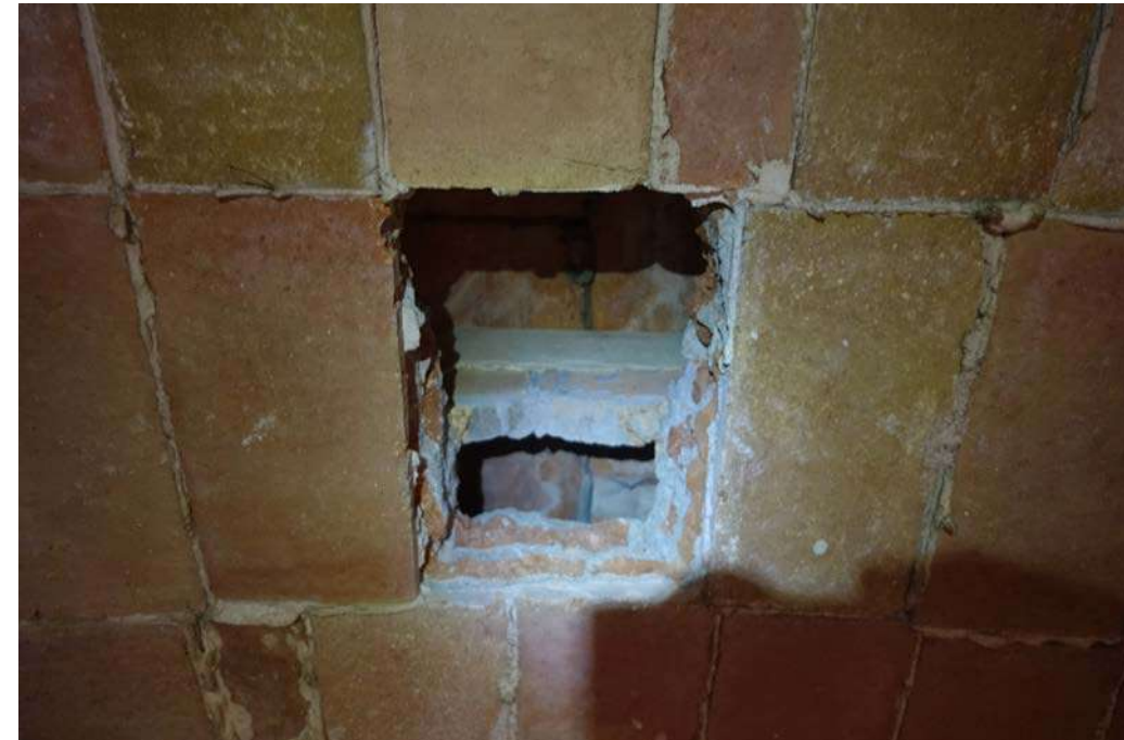
Volta ceràmica tipus V3
