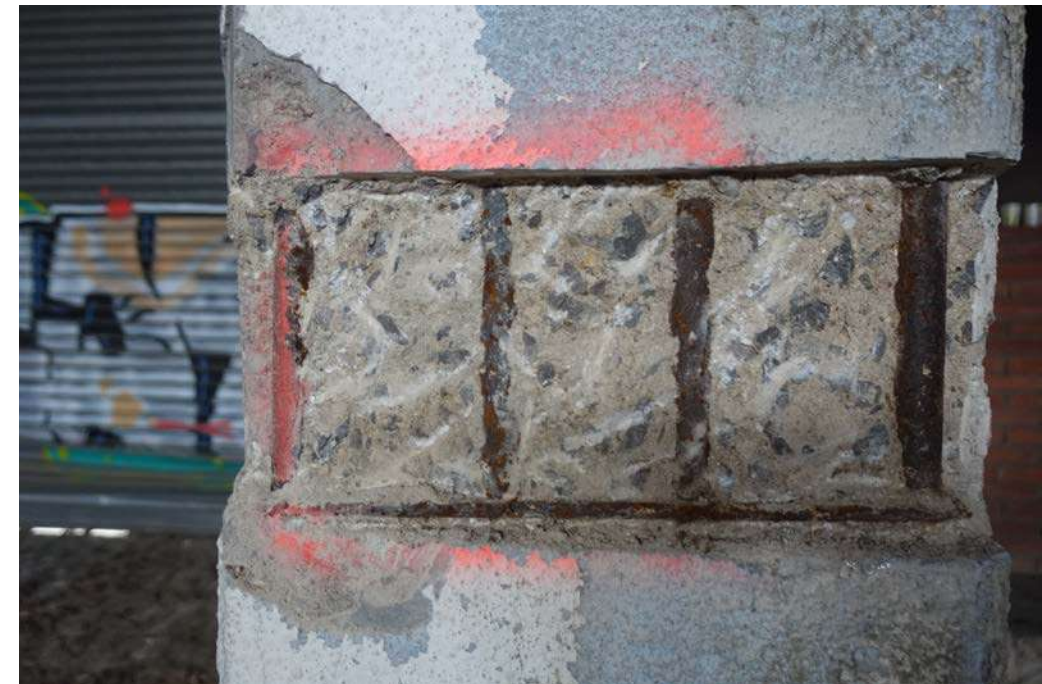
Pilar formigó armat a l'edifici annex
