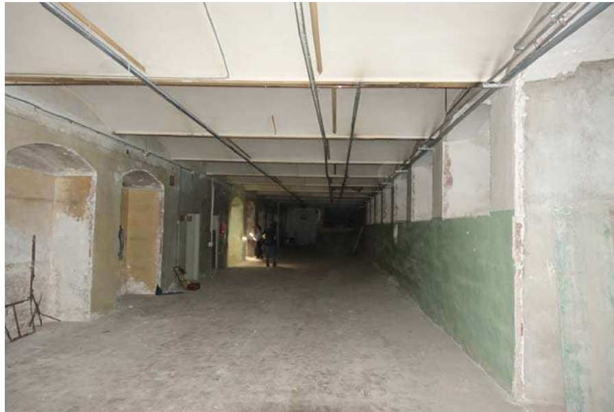
F13. SALA, P.SOTERRANI, EDIFICI OFICINES
