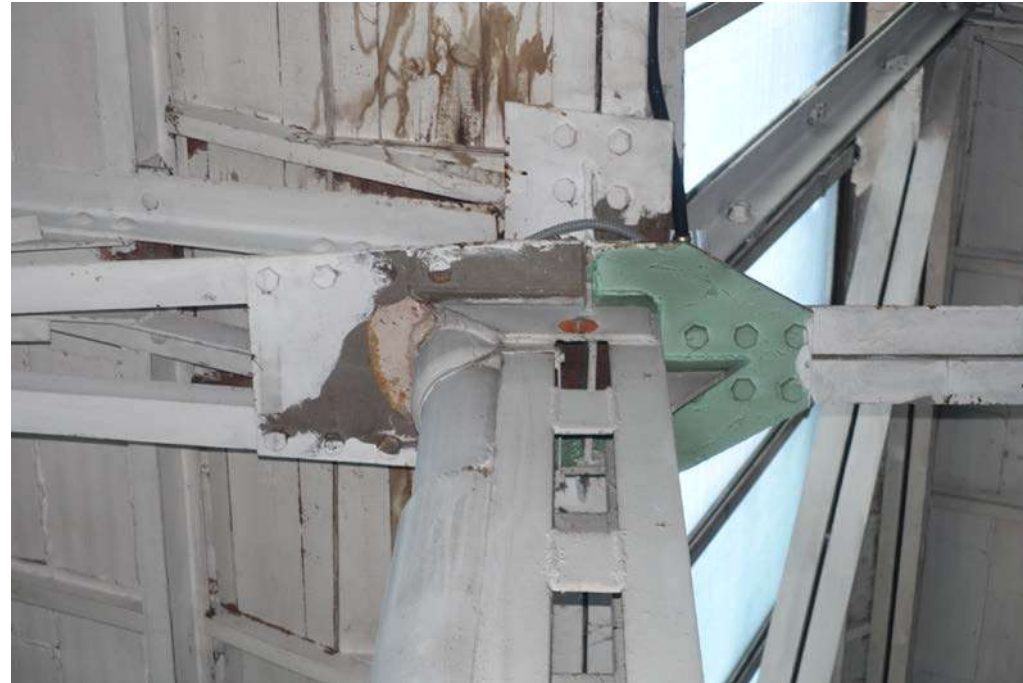
Pilar metàl·lic compost a base de 2 perfils UPN connectats
