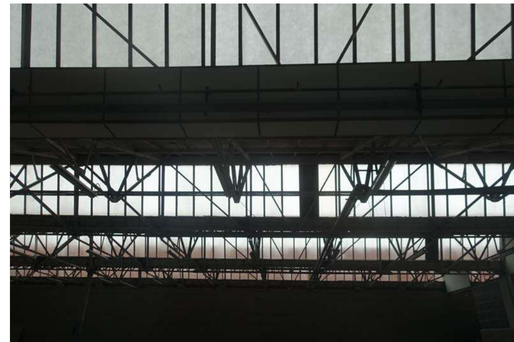
Jàssera tipus Pratt i encavallades invertides nau producció
