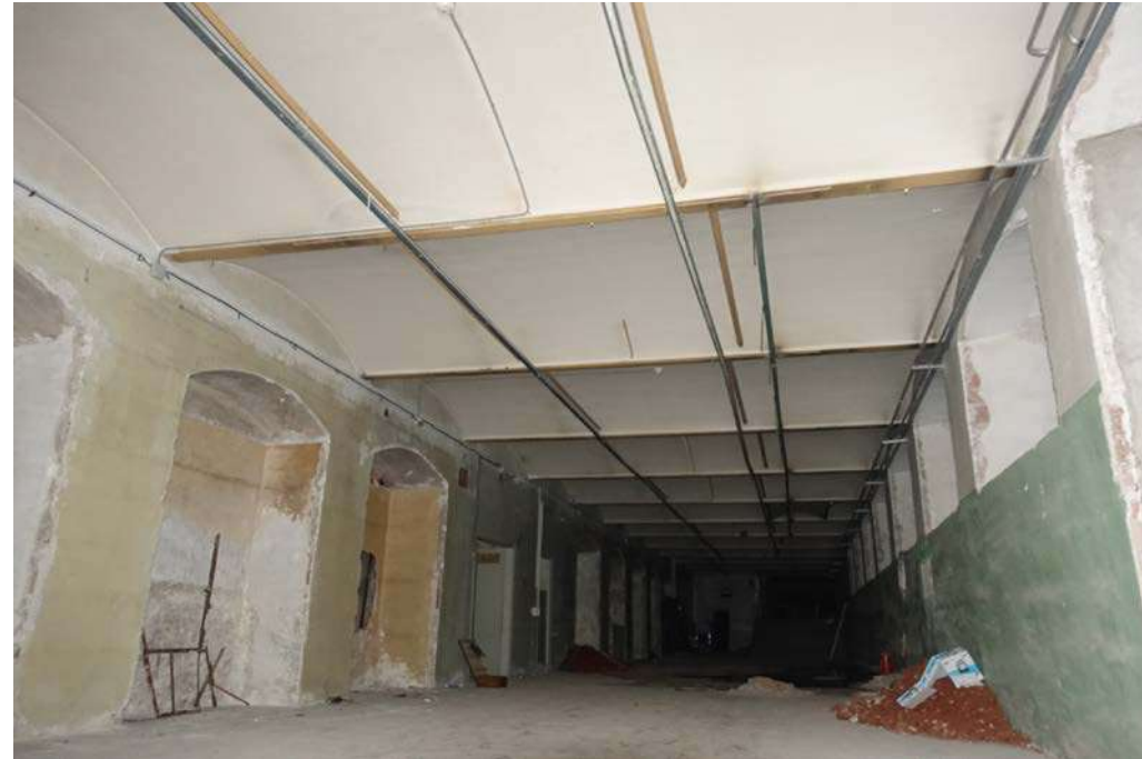
Volta ceràmica tipus V2
