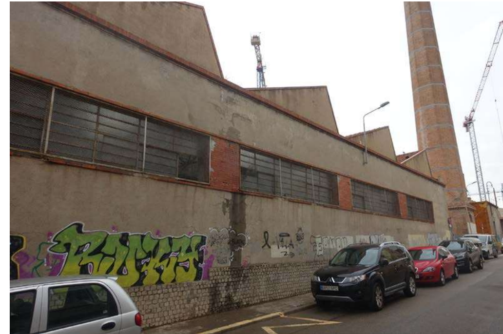
Fusteries originàries i pilastres obra vista
