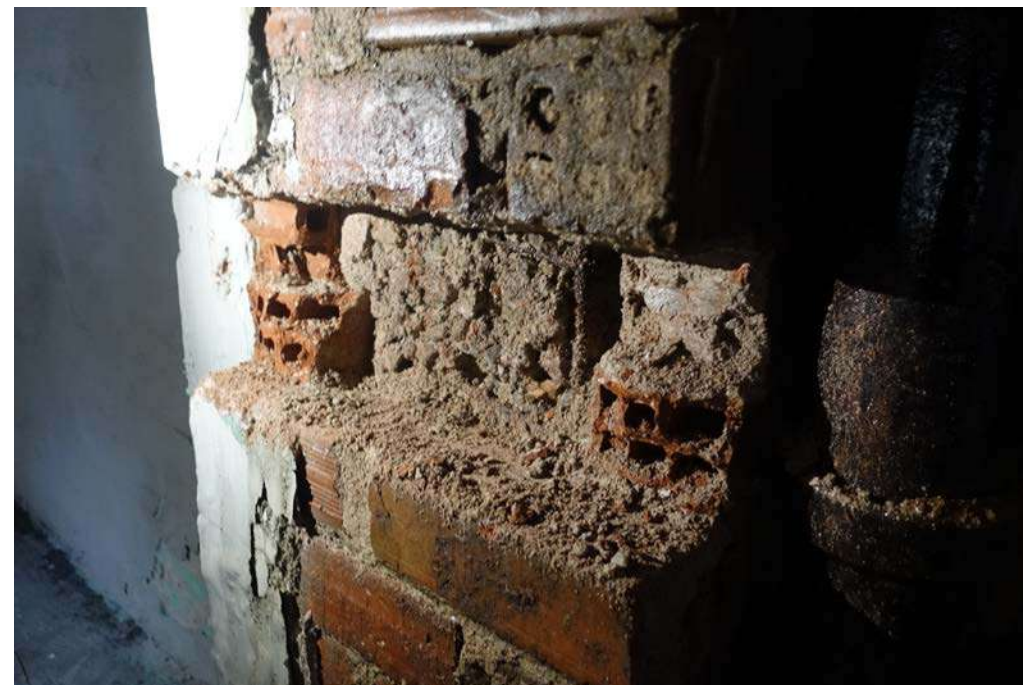
Pilar formigó armat a la façana de la nau producció revestit amb totxana
