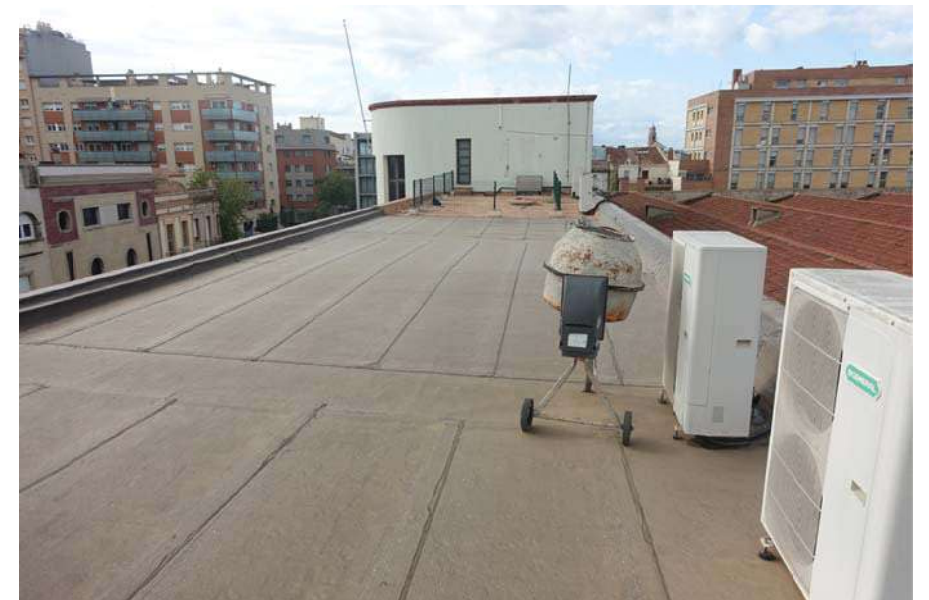
F18. TERRAT, EDIFICI OFICINES
