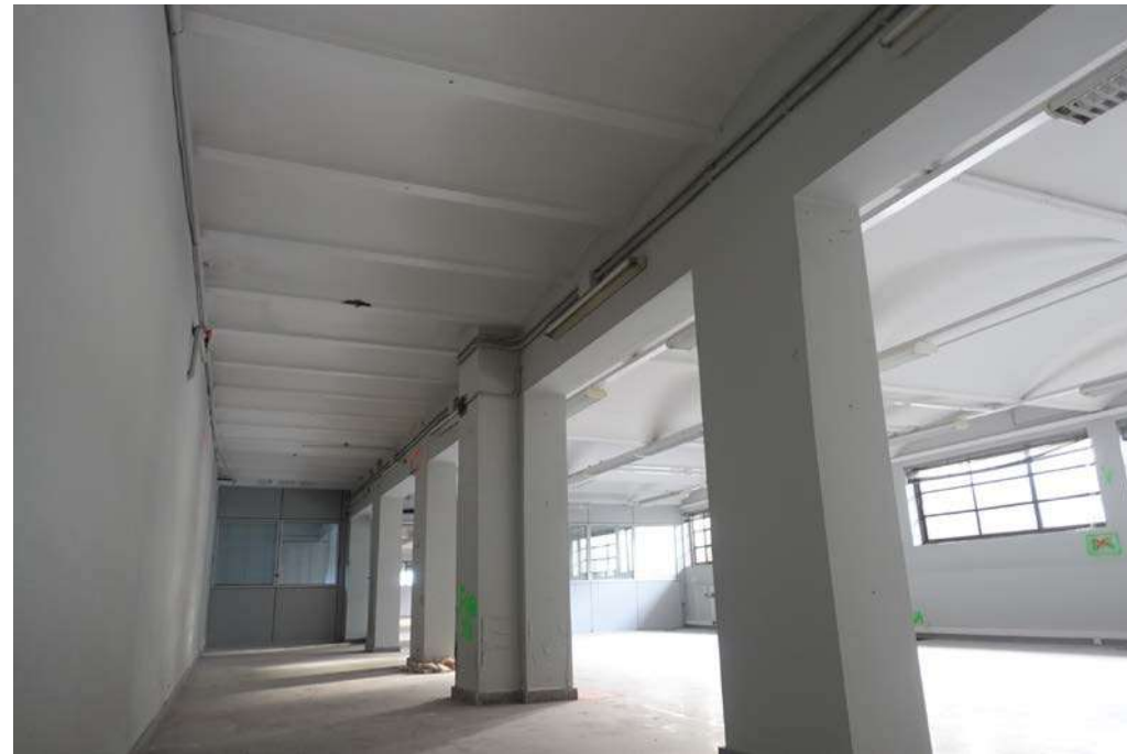
Forjat biguetes autorresistents tipus F1
