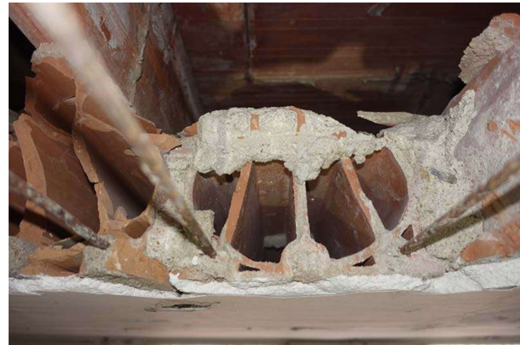
Terrat ceràmica armada tipus C
