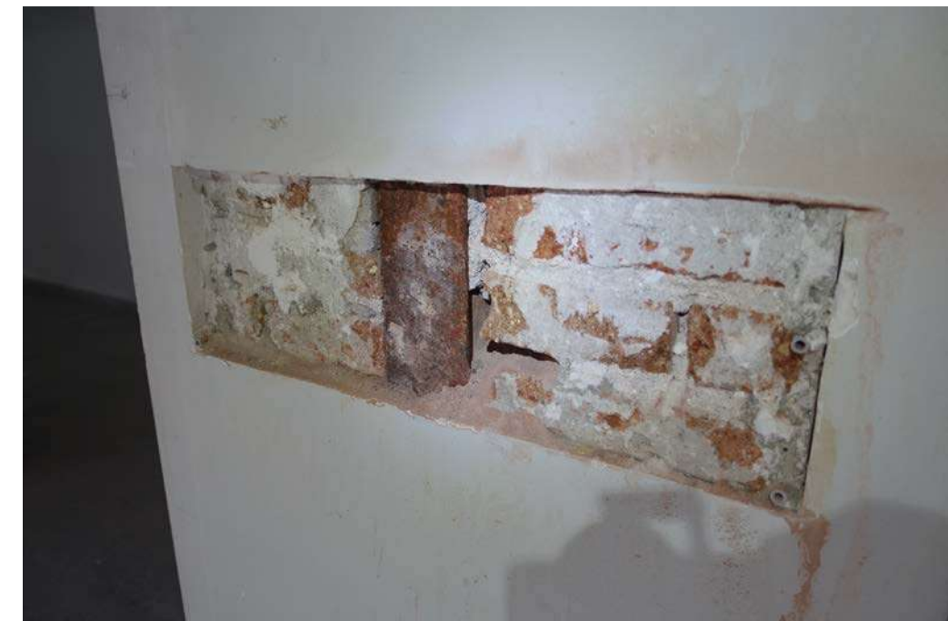
Pilar IPN 180 encastat a pilastra interior de maó massís
