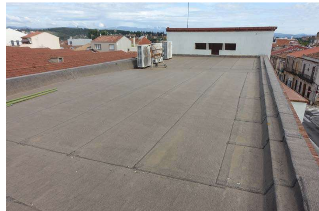
Terrat de l'edifici d'oficines
