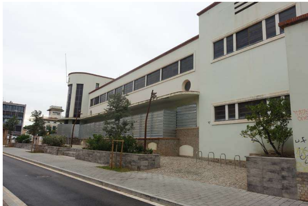
Arrebossat exterior i sòcol aplacat de pedra
