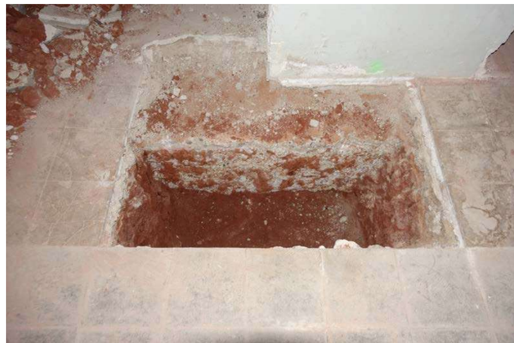
Fonamentació correguda edifici oficines
