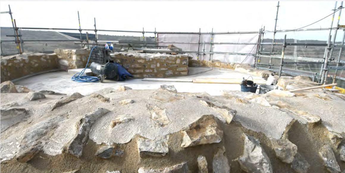
Mostra de l'acabat de l'empit, amb trabadillo, pendent de tenyir, sobre el morter de calç àeria. 2024 .10.15
