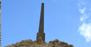
la gàrgola després del desgruixat del mur
