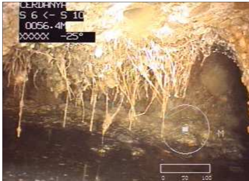
Fotografía: 17b, Nº Video: -----, 00:00:00 0m, Inicio de la inspección
