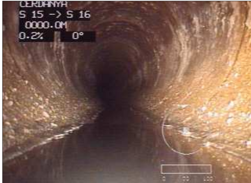
Fotografía: 29a, Nº Video: -----, 00:00:00 0m, Inicio de la inspección
