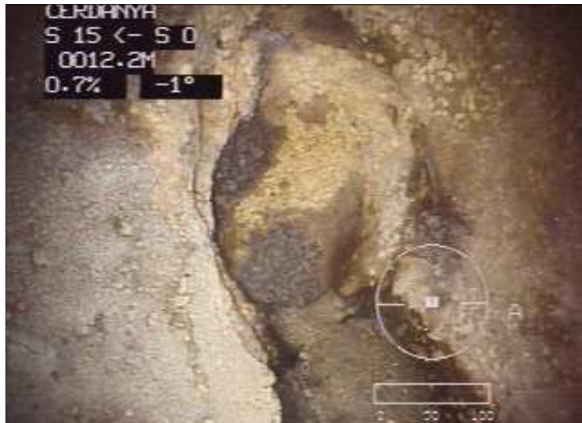
Fotografía: 27a, Nº Video: -----, 00:00:59 12,2m, 1 TUB PART ESQUERRE
