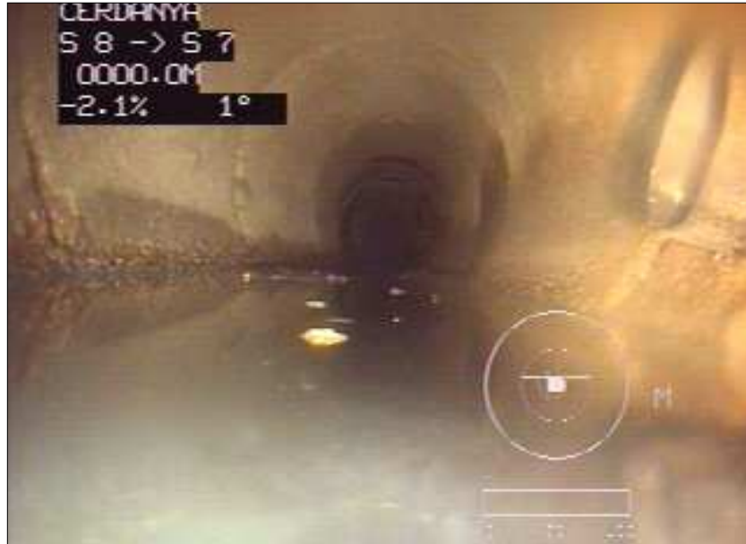
Fotografía: 3a, Nº Video: -----, 00:00:00 0m, Inicio de la inspección 1 TUB PART DRETA
