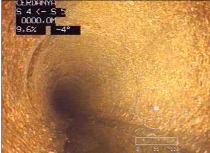
Fotografía: 10a, Nº Video: -----, 00:00:00 0m, Inicio de la inspección
