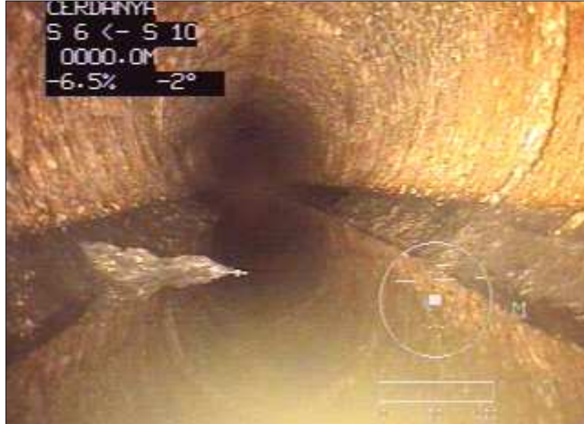
Fotografía: 17a, Nº Video: -----, 00:00:00 0m, Inicio de la inspección
