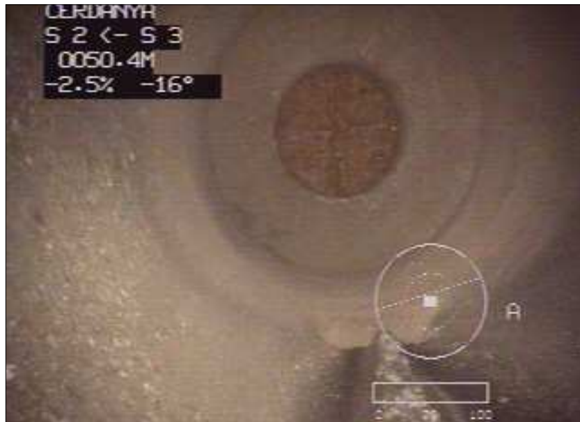
Fotografía: 21a, Nº Video: -----, 00:03:06 50,4m, Fin de la inspección, POU 3 1 COLLECTOR PART DRETA I TUB
