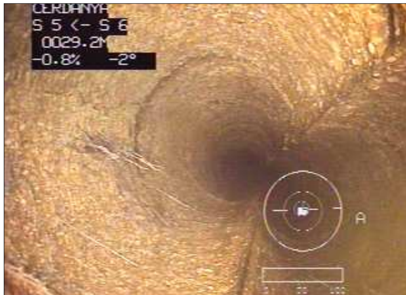
Fotografia: 14a, N° Video: -----, 00:03:31 29,2m, PUNTS DE ARRELS PART SUPERIOR
