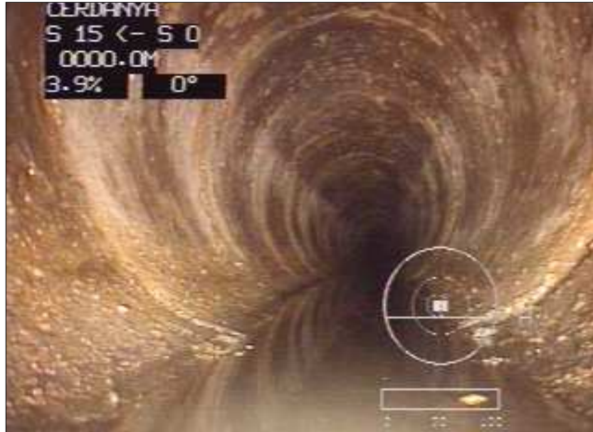
Fotografía: 26a, Nº Video: -----, 00:00:00 0m, Inicio de la inspección
