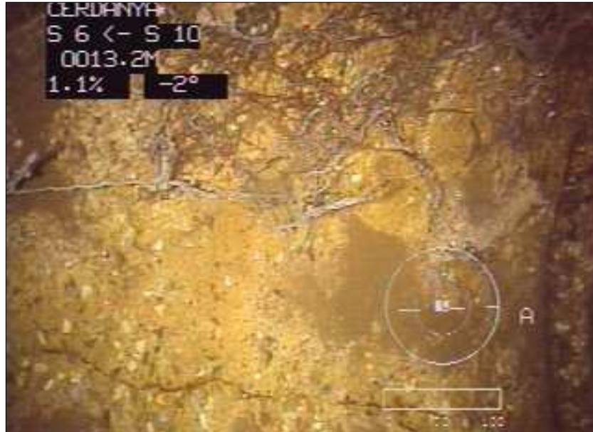
Fotografía: 18a, Nº Video: -----, 00:01:26 13,2m, ESQUEDAS DRETA I ESQUERRE MES ARRELS
