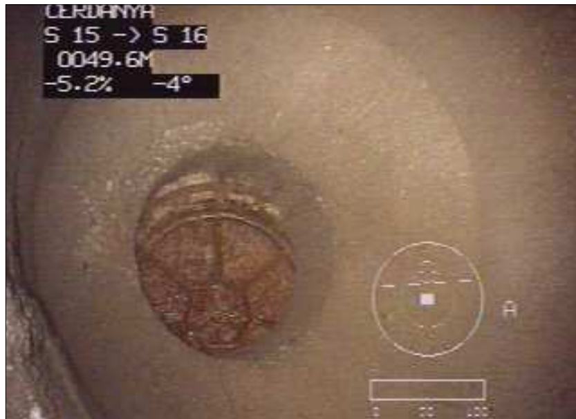
Fotografía: 30a, Nº Video: -----, 00:03:40 49,6m, Fin de la inspección
