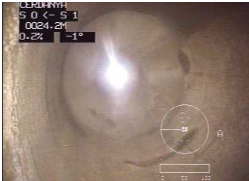
Fotografia: 25a, N° Video: -----, 00:01:35 24,2m, Fin de la inspección
