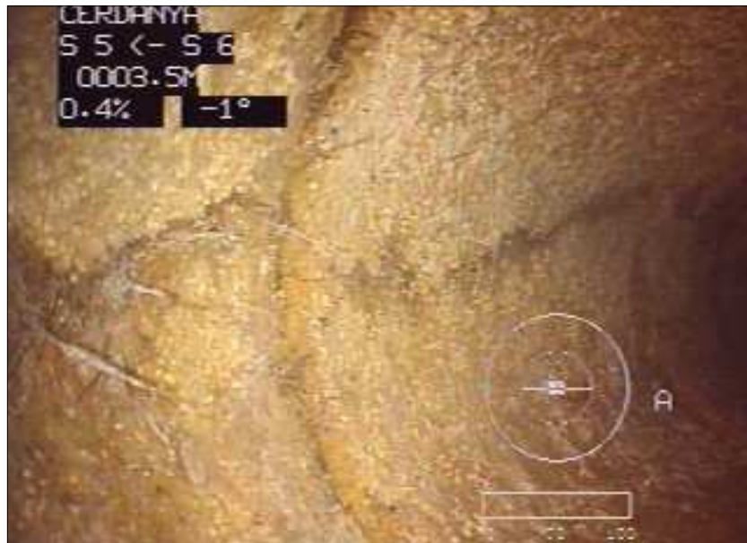
Fotografía: 13a, Nº Video: -----, 00:00:56 3,5m, ESQUERDA I ARRELS PART SUPERIOR
