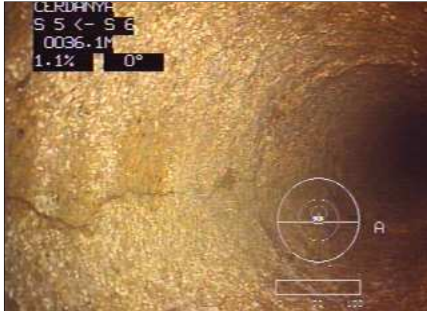
Fotografía: 15b, Nº Video: -----, 00:04:15 36,1m, ARRELS I ESQUERDAS PART SUPERIOR
