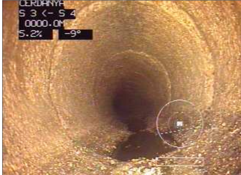
Fotografía: 7a, Nº Video: -----, 00:00:00 0m, Inicio de la inspección
