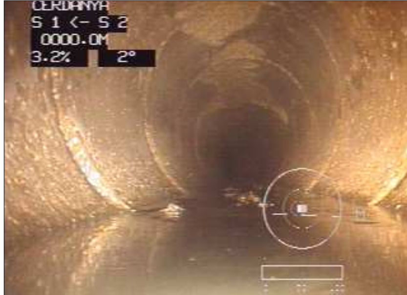
Fotografía: 22a, Nº Video: -----, 00:00:00 0m, Inicio de la inspección
