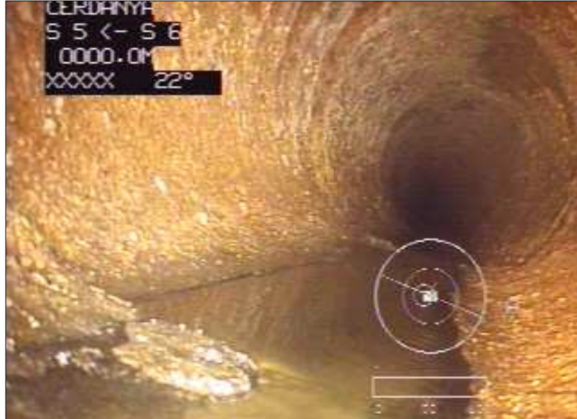
Fotografía: 12a, Nº Video: -----, 00:00:00 0m, Inicio de la inspección
