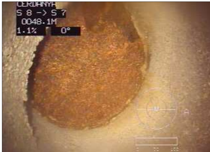
Fotografía: 6a, Nº Video: -----, 00:03:28 48,1m, Fin de la inspección
