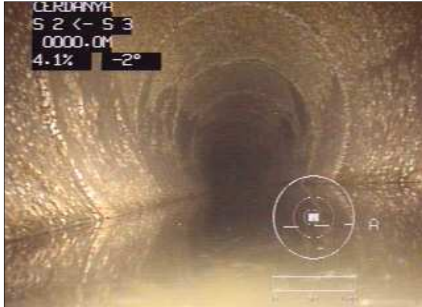
Fotografía: 20a, Nº Video: -----, 00:00:00 0m, Inicio de la inspección
