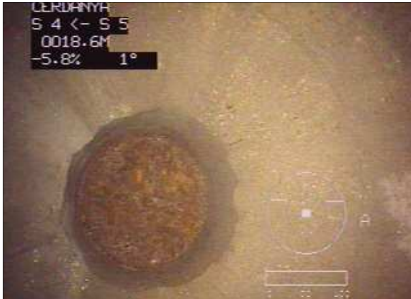
Fotografía: 11a, Nº Video: -----, 00:02:37 18,6m, Fin de la inspección, POU S 5
