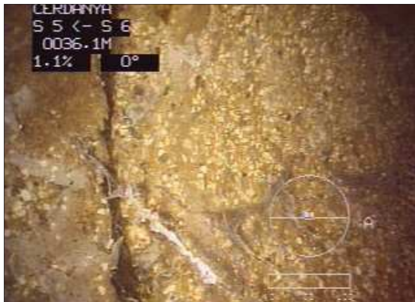
Fotografia: 15a, N° Video: -----, 00:04:15 36,1m, ARRELS I ESQUERDAS PART SUPERIOR
