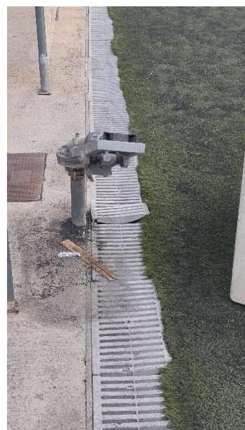
Detalls dels canons de reg i la canaleta
