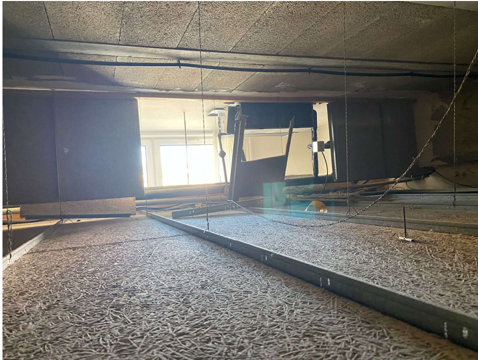
Fotografia 3. Fals sostre que actúa com a plènum dels actuls equips de climatització
