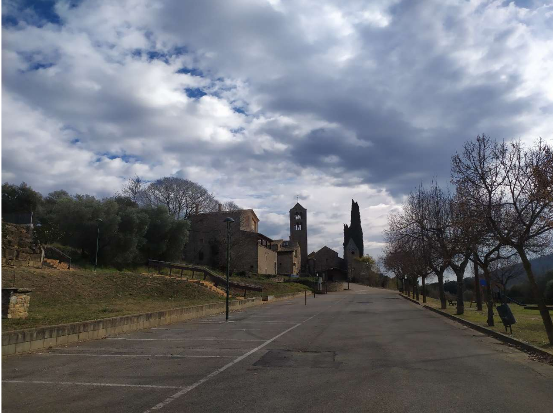
Foto 1: Actuació 1. Avinguda de l'Església
