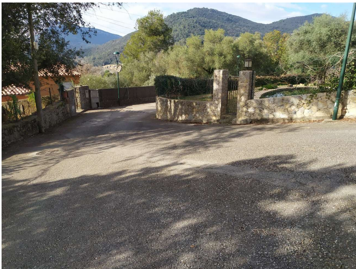
Foto 35: Actuació 1, carrer de l'Església creuament amb Passatge Alzina
