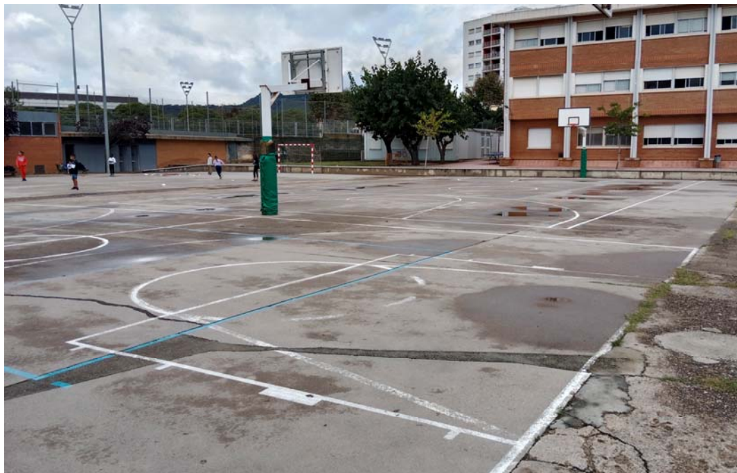
Pista poliesportiva Estat Actual - Zona Nord-oest
