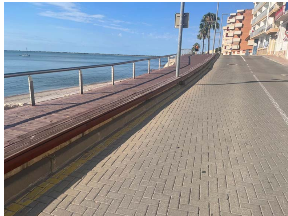
Fotografia 2: Zona de treball 1
