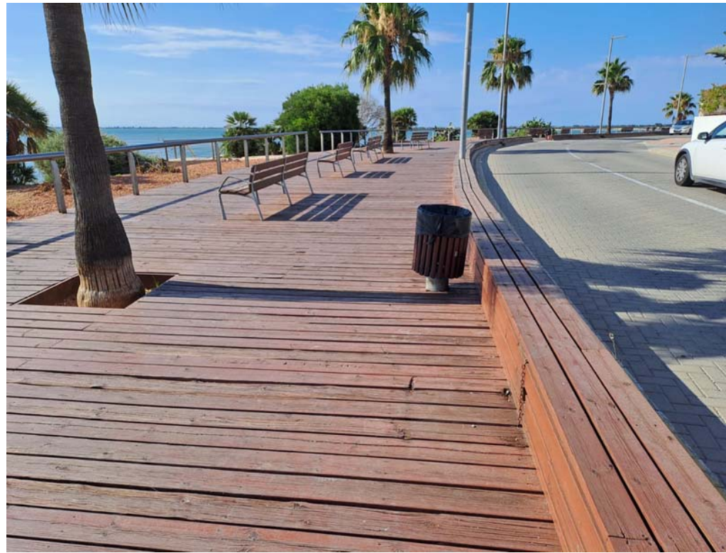
Fotografia 9: Zona de treball 3
