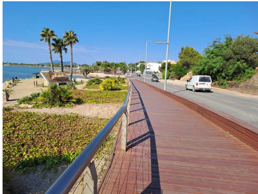
Fotografia 10: Zona de treball 4
