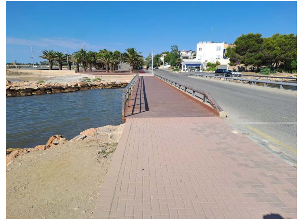
Fotografia 11: Zona de treball 4
