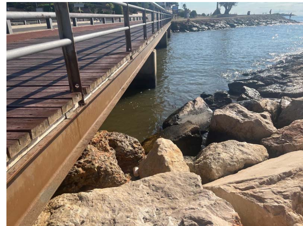
Fotografia 12: Zona de treball 4
