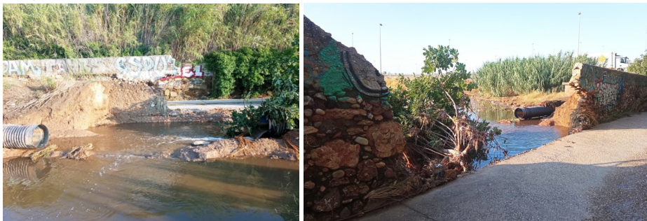
Trencament infraestructura de reg i ensorrament de mur.
