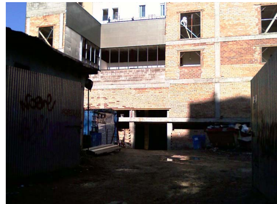
Imatge C. Estat actual de l'obra de la façana sud. No apareix mur de contenció
