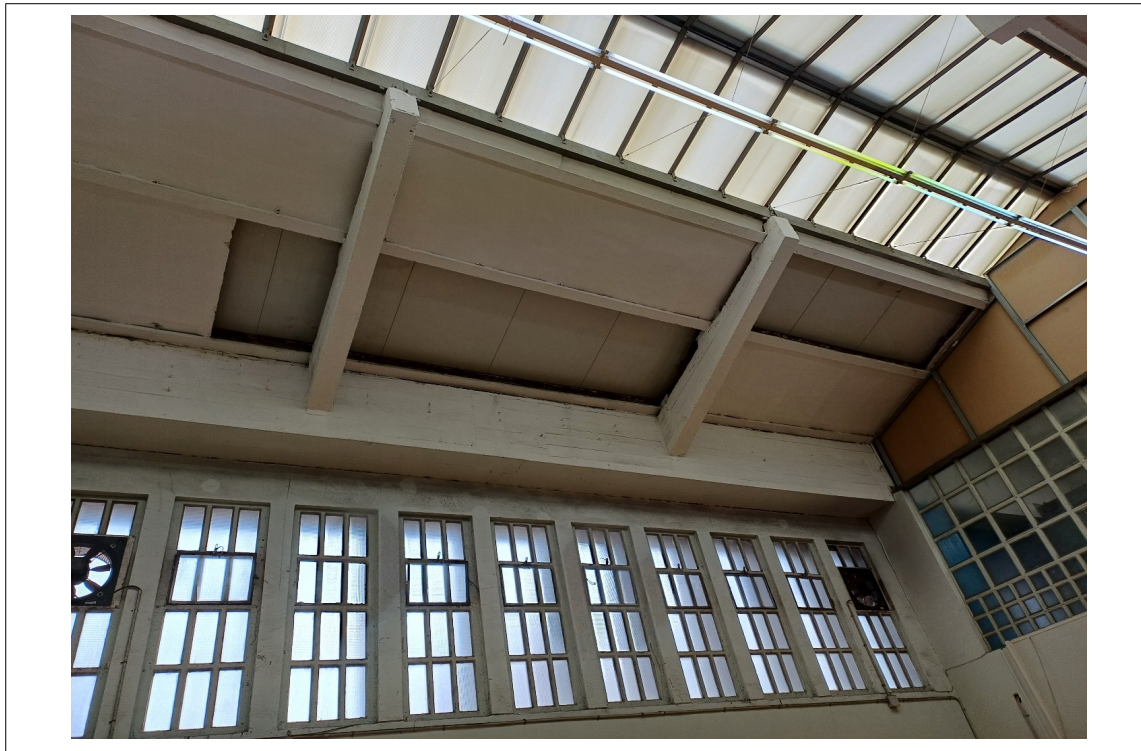
Zona del Sostre del gimnàs a reparar
