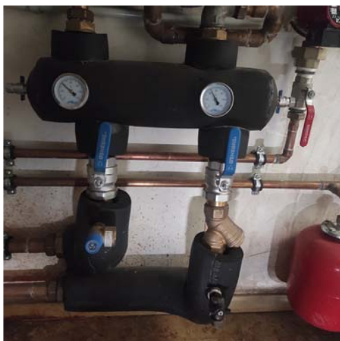
Circuits distribució, vas d'expansió i acumulador ACV COMFORT E100 75 litres
