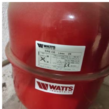
Vas expansió WATTS 24 litres
