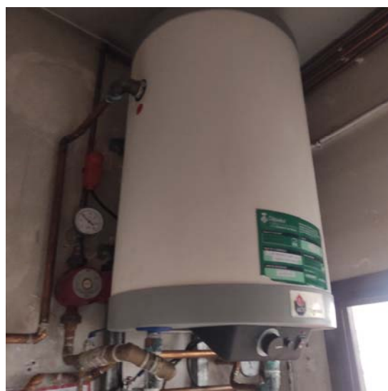
Circuits distribució, vas d'expansió i acumulador ACV COMFORT E100 75 litres
