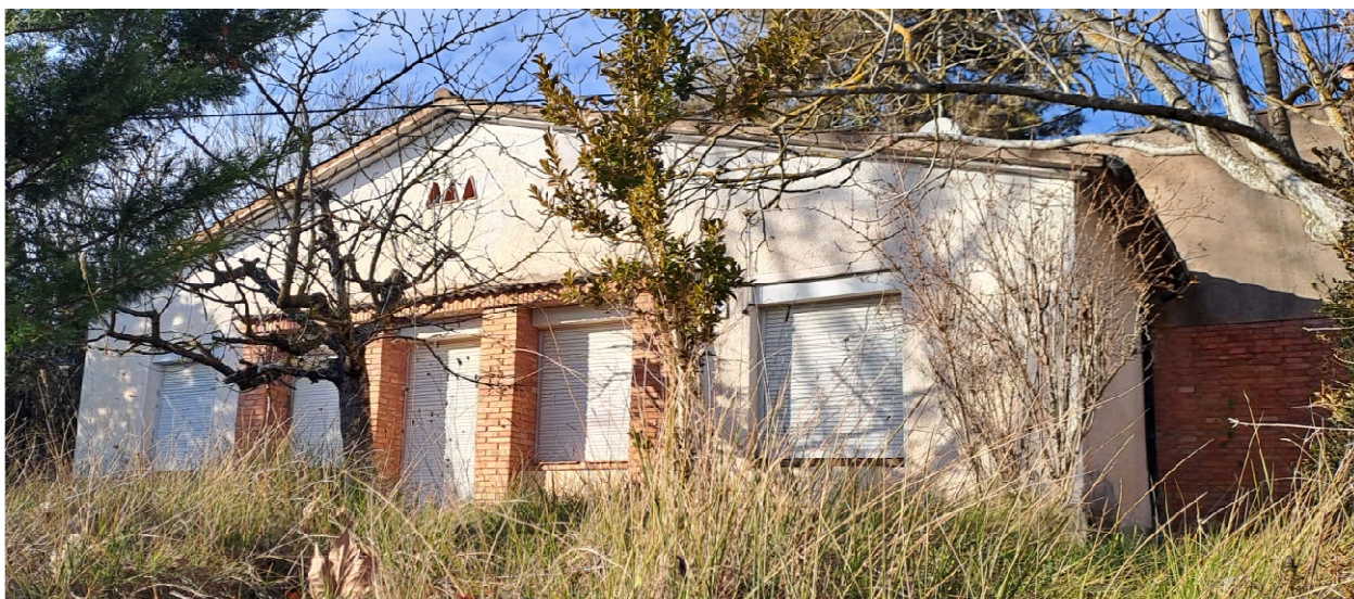
Estat actual de la façana sud de l'edifici, oberta al jardí.
