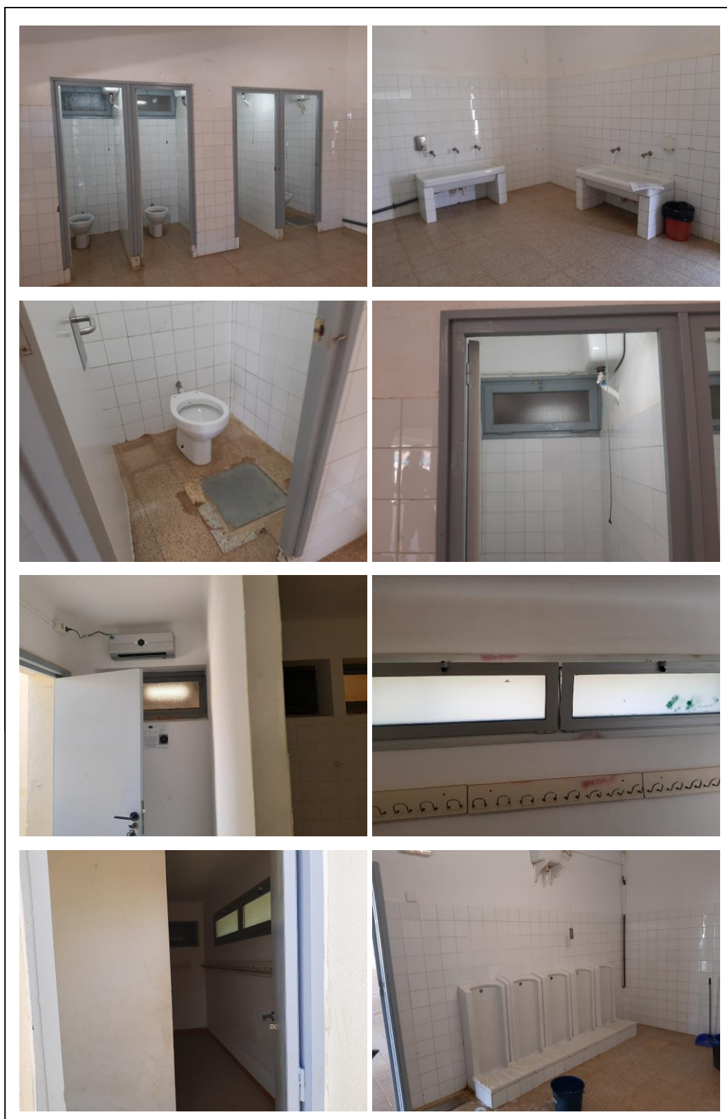
Actuació 3. Estat actual de vestidors
