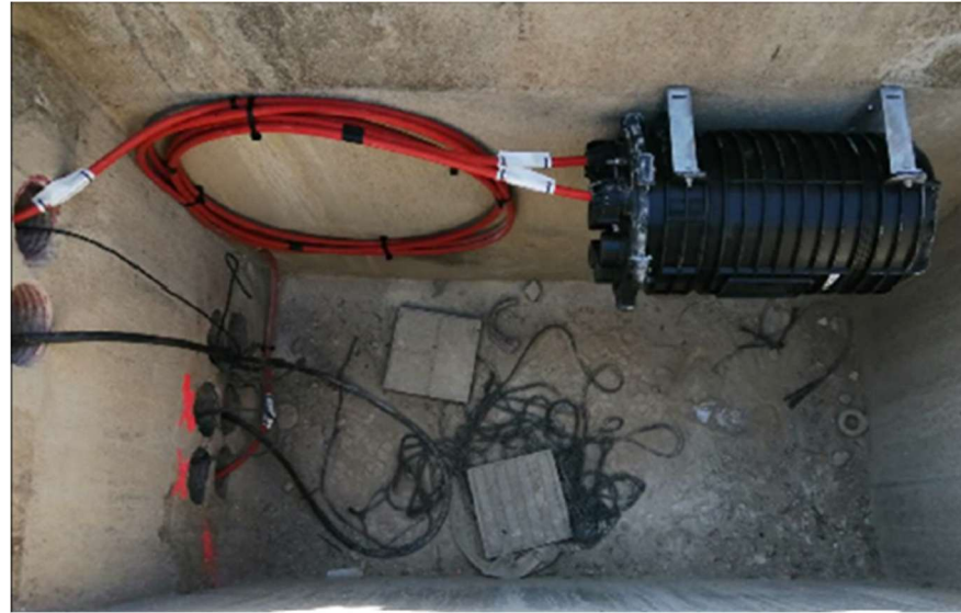
Il·lustració 11: Caixa d'empulament tipus FIST
