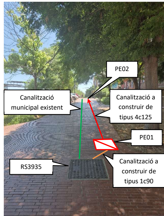
Il·lustració 6: Nova canalització convencional de tipus 1c90 i nova canalització convencional de tipus 4c125 entre el pericó RS3935 existent i el nou pericó PE02
