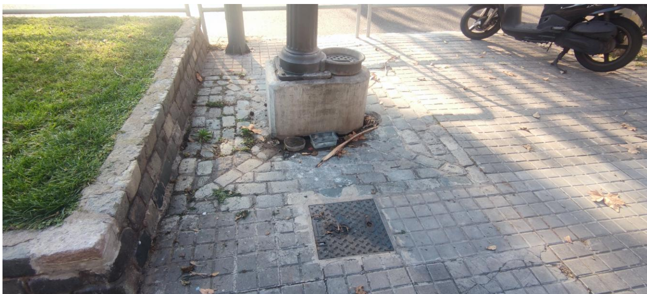
▲ Canvi de paviment en la zona pròxima a la font
