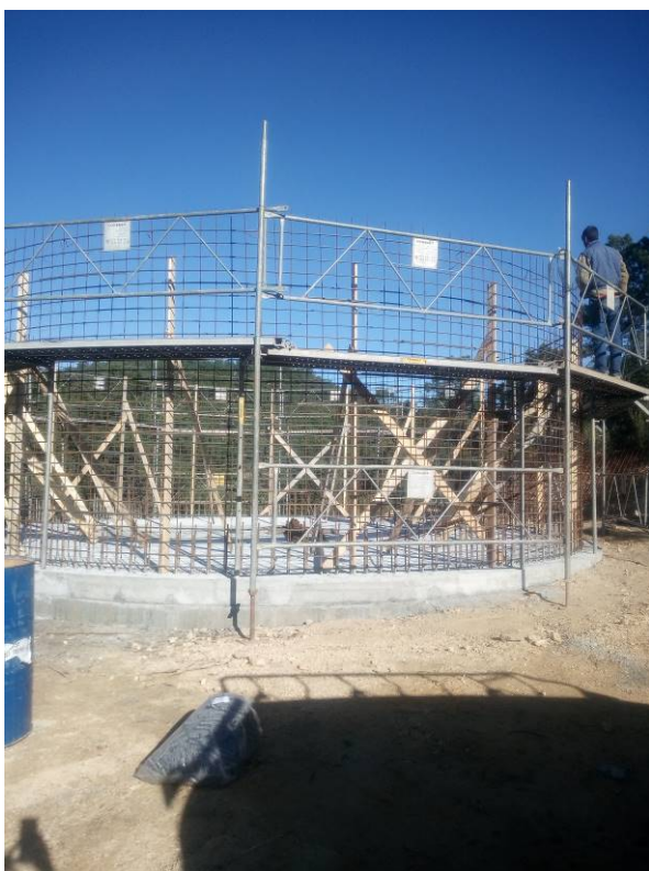
Exemple de la construcció de l'armadura i l'encofrat dels murs
