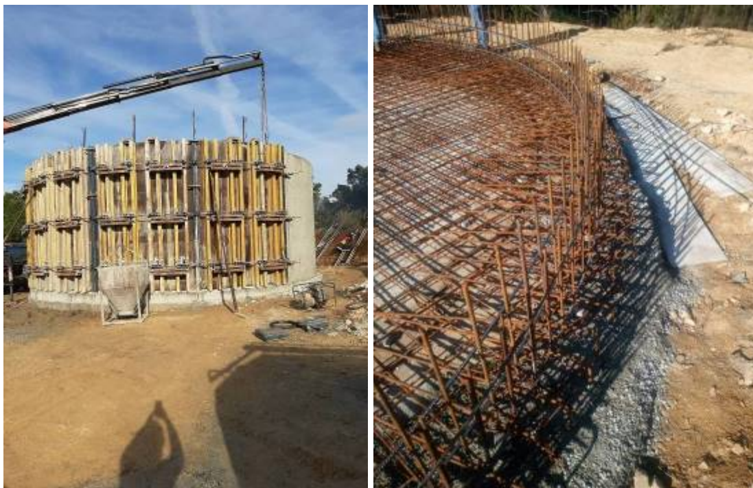
Imatge 22: Exemple d'encofrat tipus circular i armat de la sabata del punt d'aigua.
