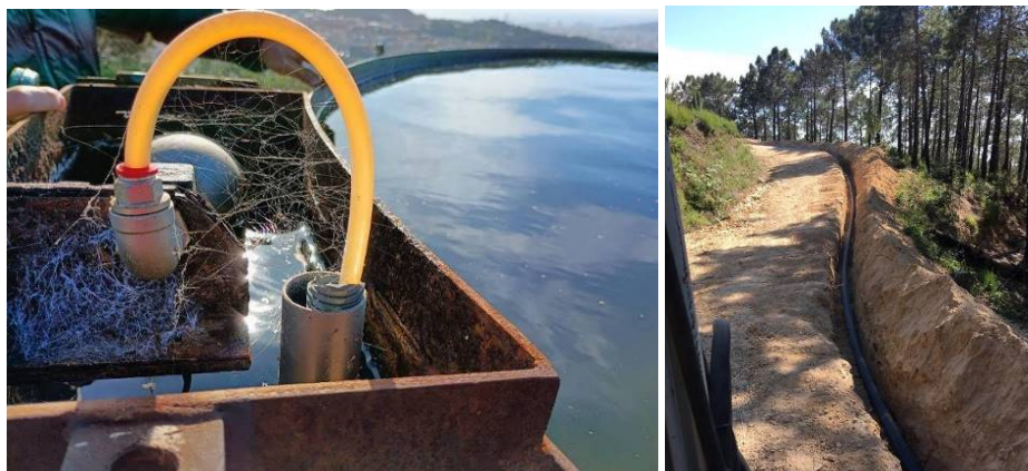
Exemple del sistema d'abastament automàtic amb boia i la instal·lació del tub d'abastiment
