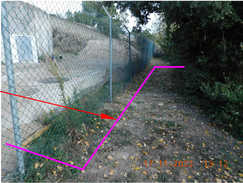
Nova rasa per a pas de tub de desguàs
