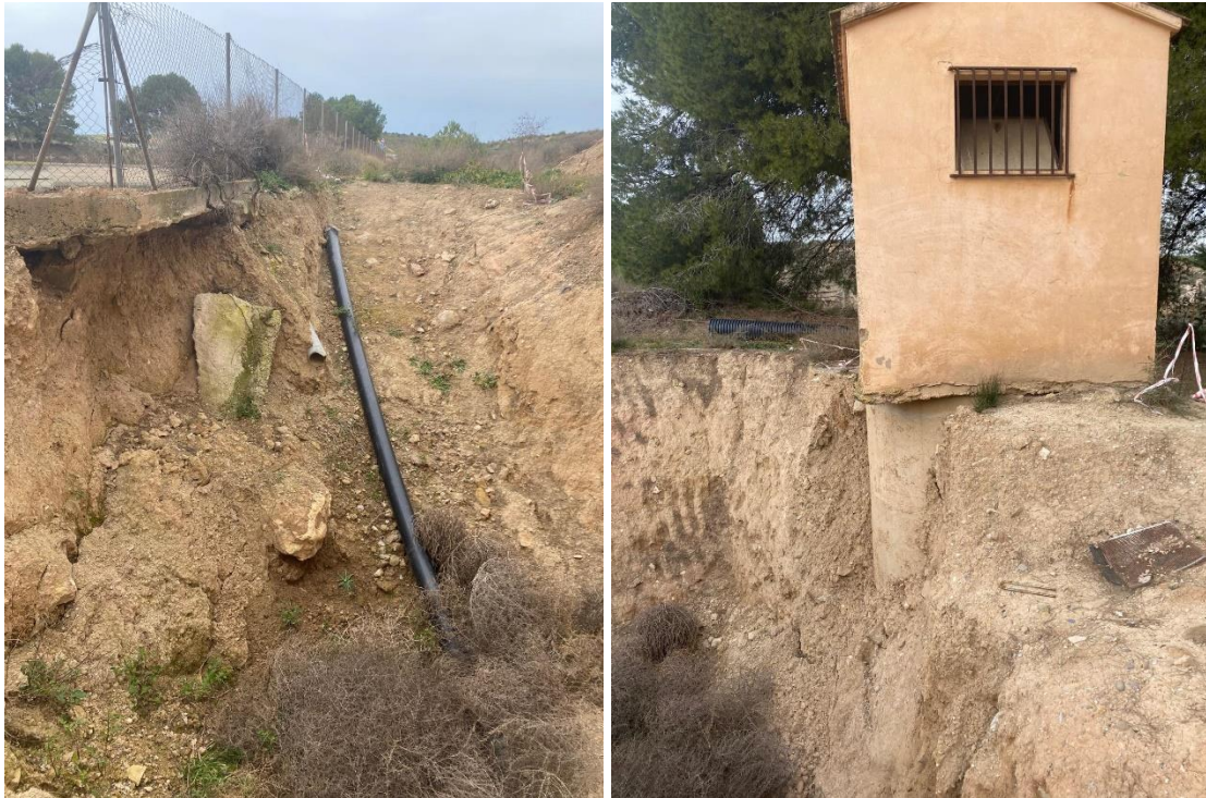
Cala existent a la sortida del tub d'abastament de la ETAP
