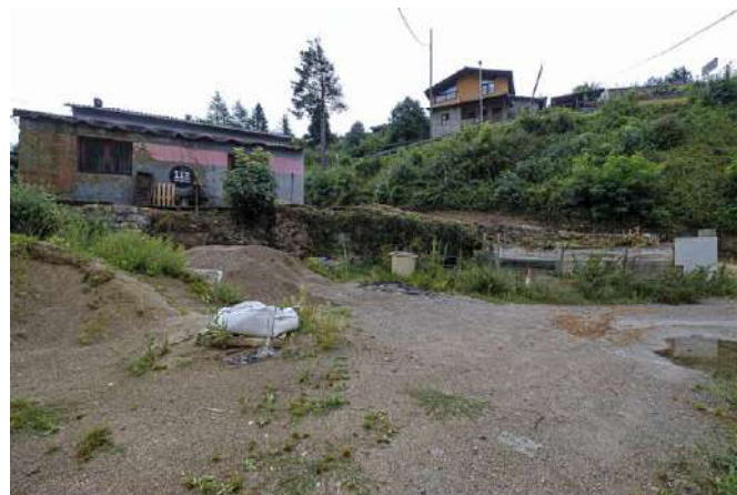
Mur de maçonneria i edifici dels bombers.
