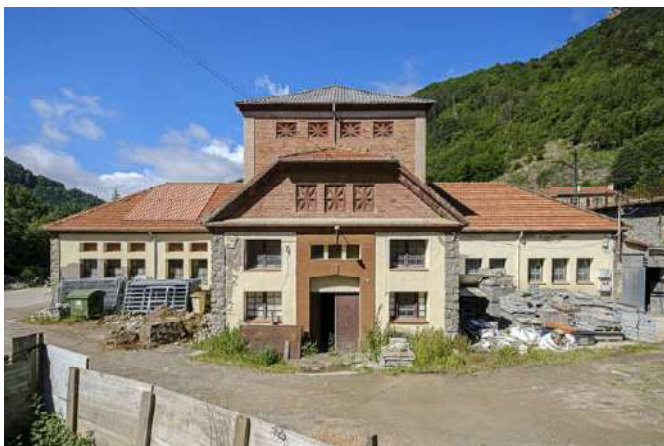
Escorxador. Façana est.
