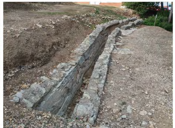
Vista detall des de l'extrem Est del tram de l'Aqüeducte
