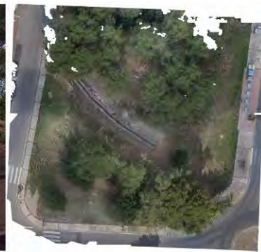
Vista aèria de l'Aqüeducte i entorn
