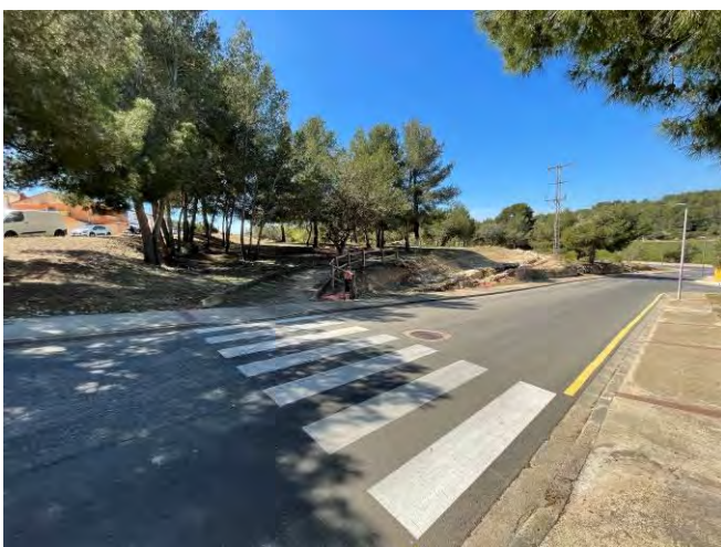
Vista de l'accés en rampa des de l'extrem Est del tram de l'Aqüeducte
