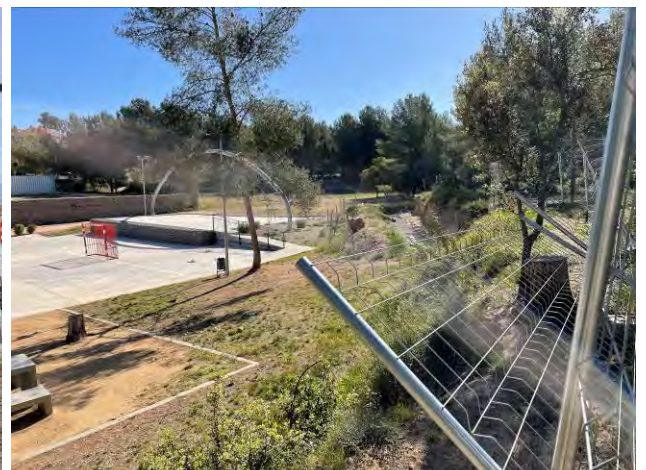
Vista de l'entorn des de l'extrem Oest del tram de l'Aqüeducte
