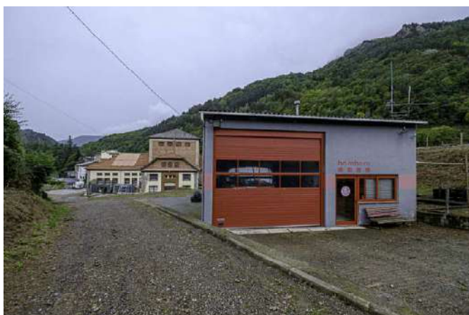
Accès des de la carretera de Bruguera
