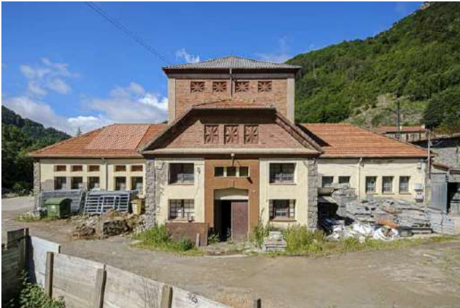
Escorxador. Façana est.
