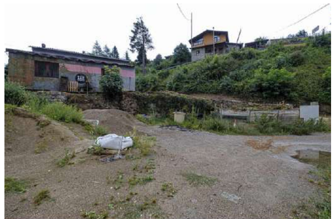
Mur de maçonneria i edifici dels bombers.
