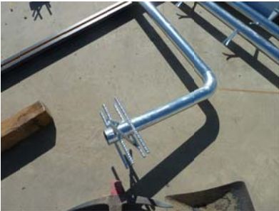
Detall pota del rail amb ancoratges i connectors
