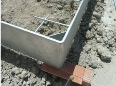
Reforç cantonada, connectors i acabat de les arestes.
