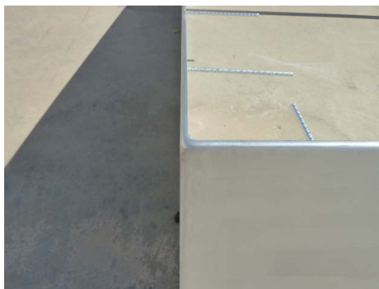
Arestes "arrodonides" a taller abans de galvanitzat, evitant punxes o fils que tallin, per pletines i vores.
